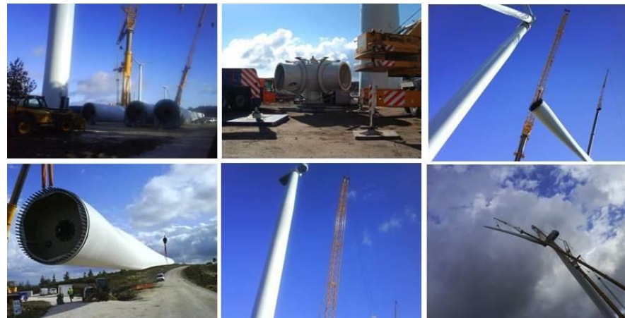
Trabalhos de transporte e montagem dos pás de um aerogerador
