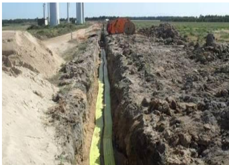
Colocação das lajetas de proteção mecânica
