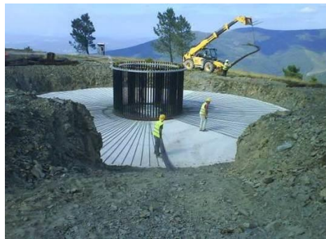
Trabalhos de armação de ferro
