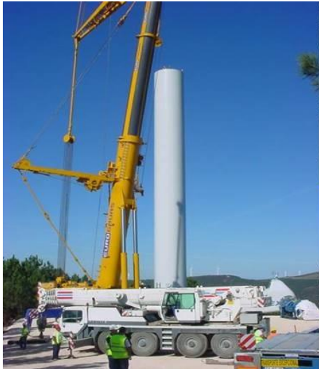
Plataforma de montagem do aerogerador
