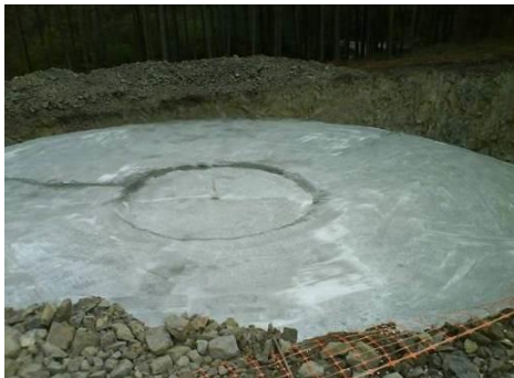
Fundação com betão de limpeza
