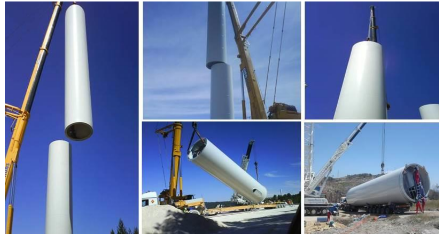
Trabalhos de montagem da torre de um aerogerador
