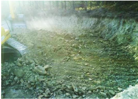
Escavação do cabouco
