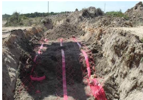
Colocação da Rede de sinalização vermelha
