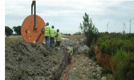
Colocação de Cabo
