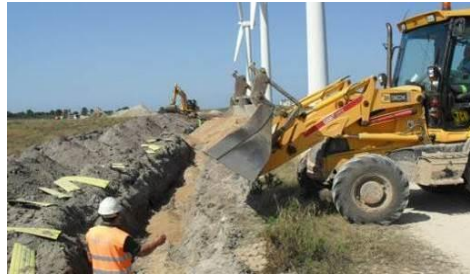
Colocação da areia na base da vala de Cabos
