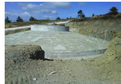
Fundação betonada e pronta para ser aterrada
