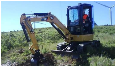
Trabalhos de Escavação da Vala
