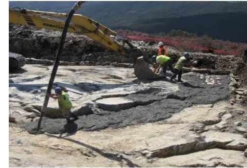
Betonagem de betão de limpeza na fundação
