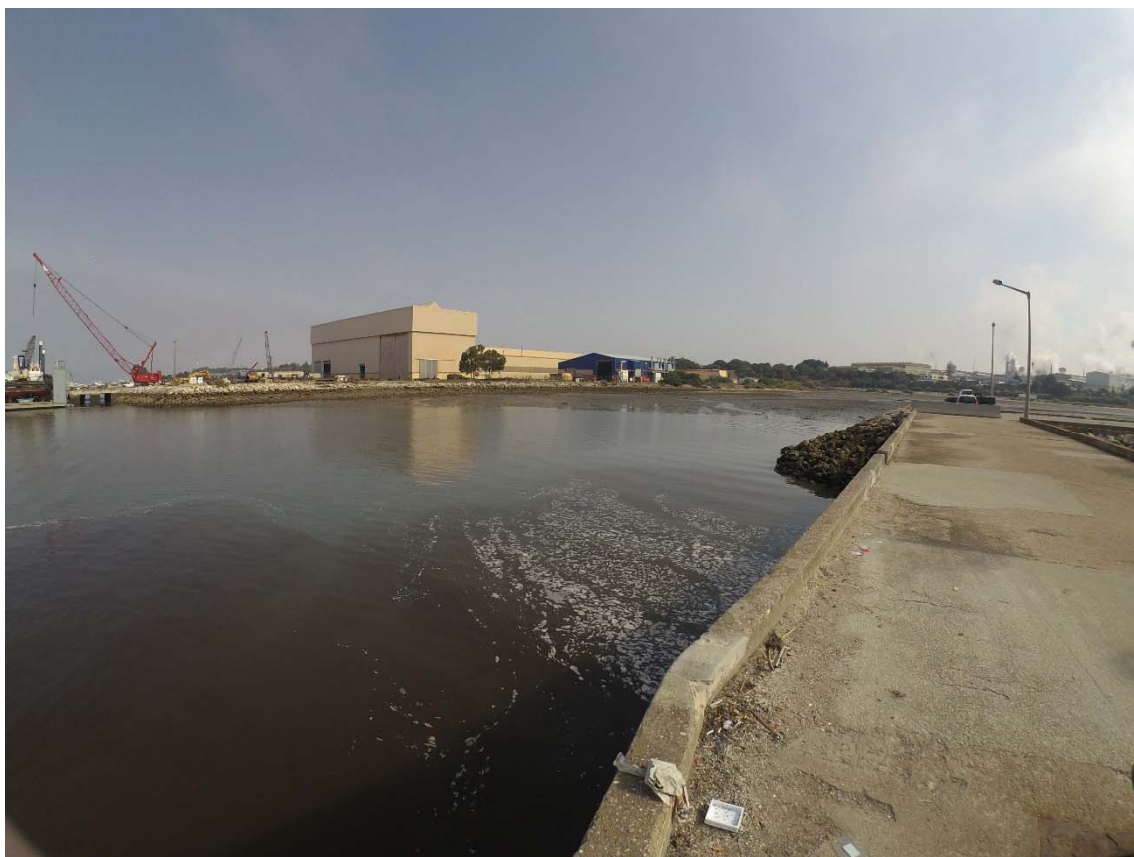
Figura 30- Aspeto da água, à entrada da caldeira, onde é visível a diferença de tonalidade e espuma associada a descargas no local.
