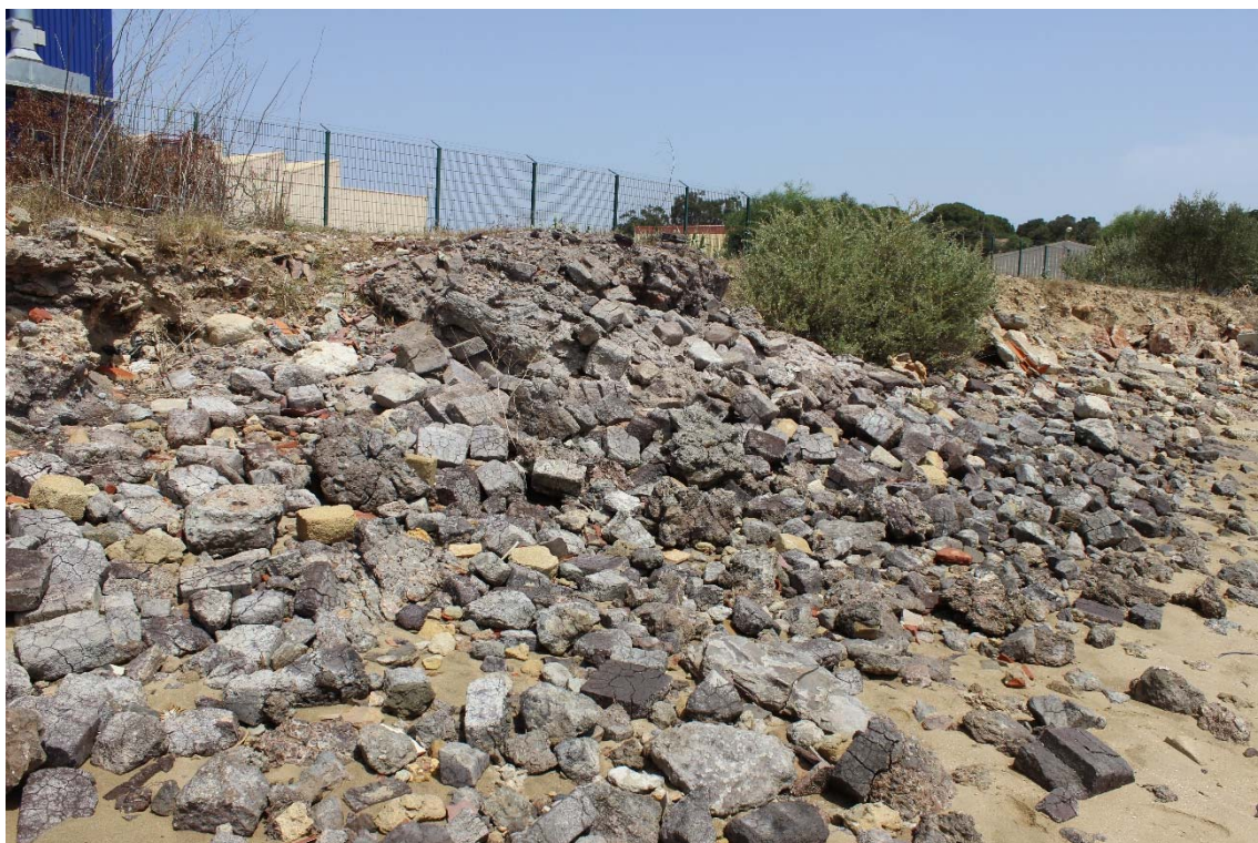
Figura 23 - Pormenor da concentração de material construção recente presente na área do projeto.
