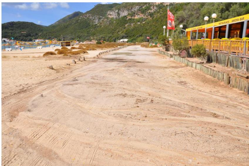
Figura 21 – Efeito negativo da estrada do Creiro na drenagem das águas pluviais, fazendo aumentar a secção de contacto com a praia e incrementando, dessa forma, o impacte das argilas na areia da praia.
