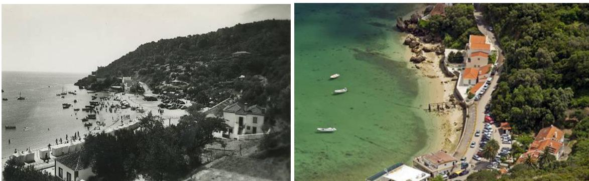
Figura 13 – Na imagem da esquerda, pormenor do parque de estacionamento original, ainda sobre o areal da praia. De notar que a utilização do espaço se fazia já de forma desadequada, tendo em conta a curvatura natural da baía <sup>(6)</sup>. Na imagem da direita, observa-se a estabilização da linha de costa, ainda hoje existente, recorrendo a um paredão contínuo.
