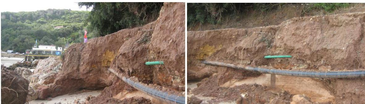
Figura 16 – Erosão do aterro construído para dar acesso à zona do Creiro, tendo ficado exposta a canalização da água <sup>(7)</sup>.
