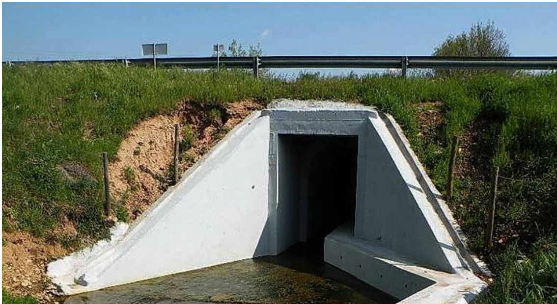
Figura 3 – Colocação de vedação nas zonas das passagens hidráulicas
