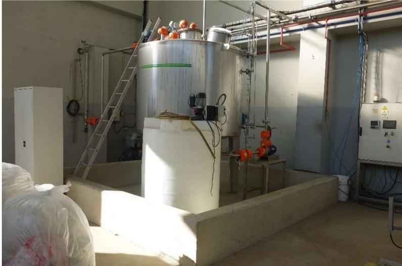
Fotografia 3.3 - Tanque de receção do ácido nítrico.
