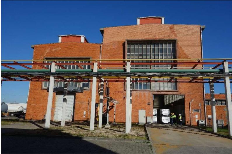
Fotografia 3.1 - *Piperack* existente junto da IENE que fornece o ácido nítrico à instalação.
