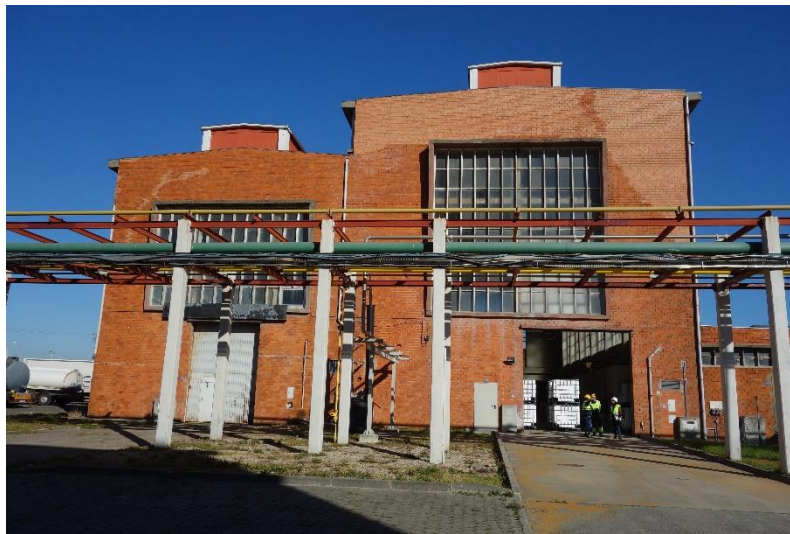
Fotografia 1 - Edifícios onde funciona a Instalação de Enchimento de Acido Nítrico em Estarreja.
