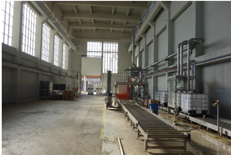
Fotografia 2 - Linhas de enchimento existentes na instalação.
