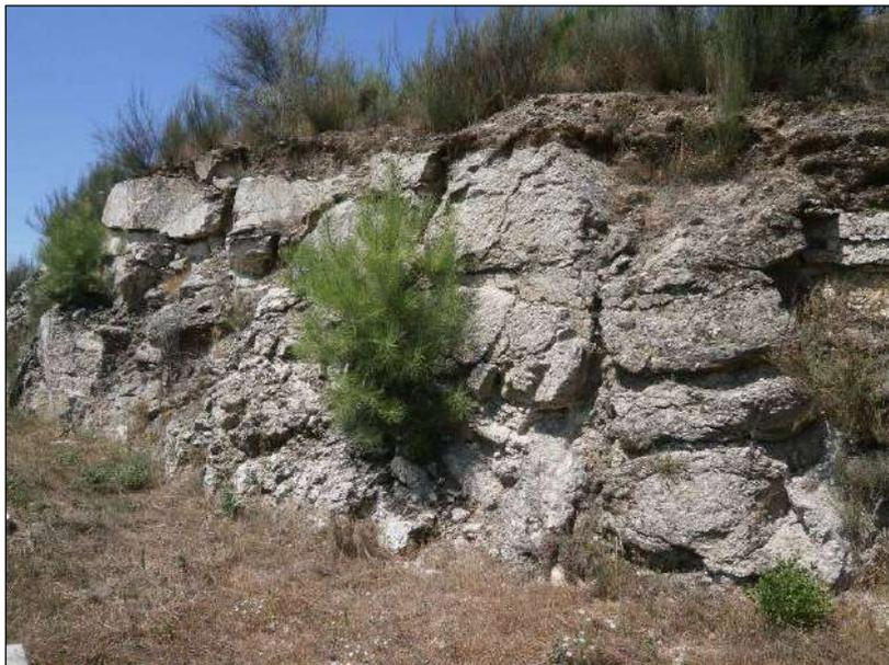
Figura 15 – Observação das principais famílias de diáclases presentes no substrato rochoso do talude a sudoeste da área em estudo, junto à EN16.
