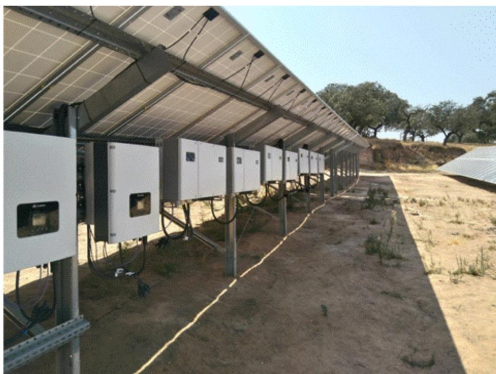
**Figura 2.8- Exemplo de inversores de string acoplados à estrutura de suporte dos módulos fotovoltaicos**
