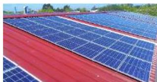
**Estrutura de suporte módulos fotovoltaicos coplanares**
