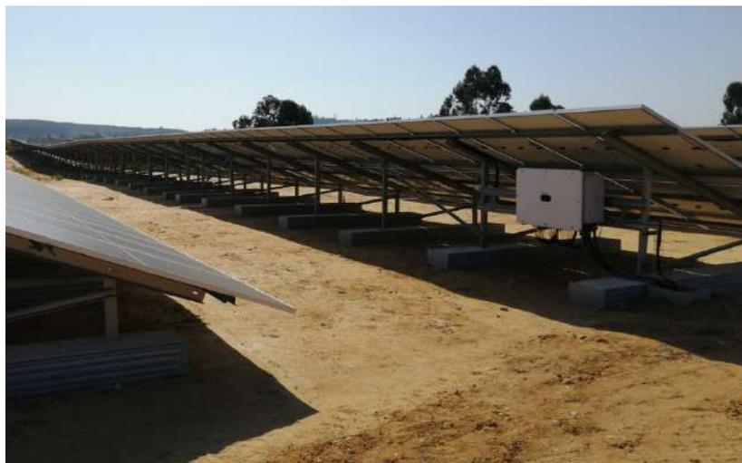
**Figura 2.2 – Exemplo de fundações de estrutura em blocos de betão assentes no solo**
