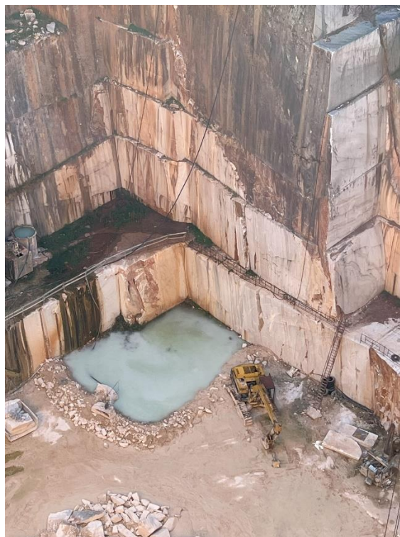
Figura 2. “Caixa” existente no último piso da exploração donde se processa, após decantação gravimétrica, a captação das águas, quer para o processo produtivo quer os excedentes em situação de maior pluviosidade.
