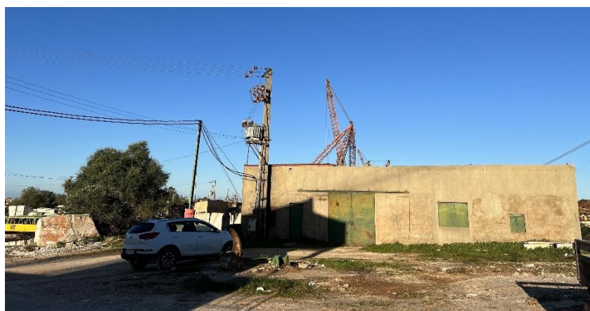
Figura 5. Instalações onde se processa o armazenamento de óleos e lubrificantes.
