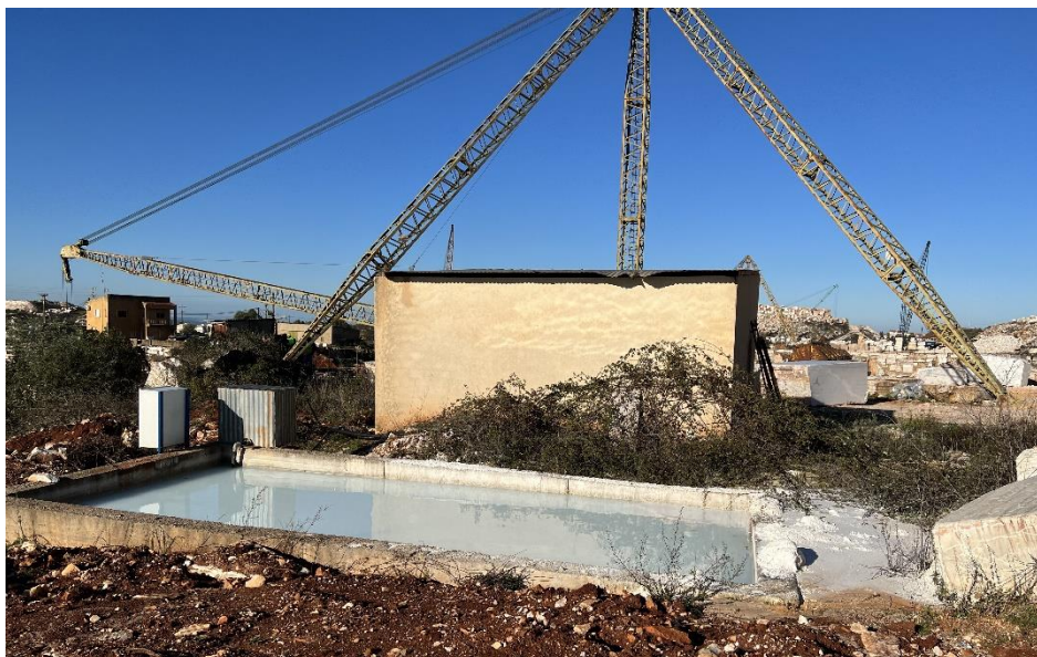
Figura 14. Tanque de decantação junto às monolâminas.
