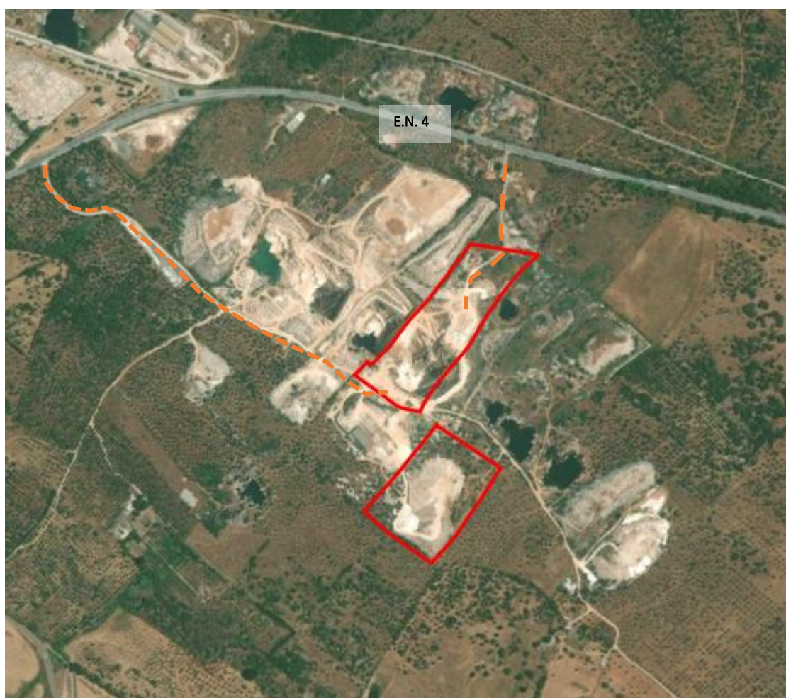
Figura 84. Vias de acesso ao concelho de Estremoz e à área em estudo.
