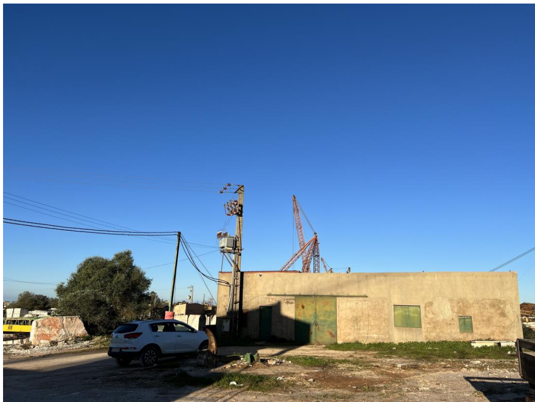
Figura 121. Local onde se processa o armazenamento de óleos e lubrificantes.
