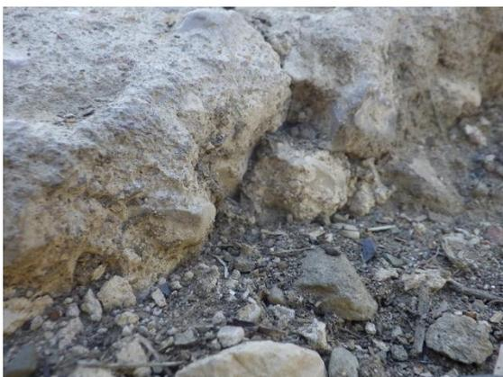
**Figura 34 –Pormenor da fratura do *opus cimenticium* (1)**
