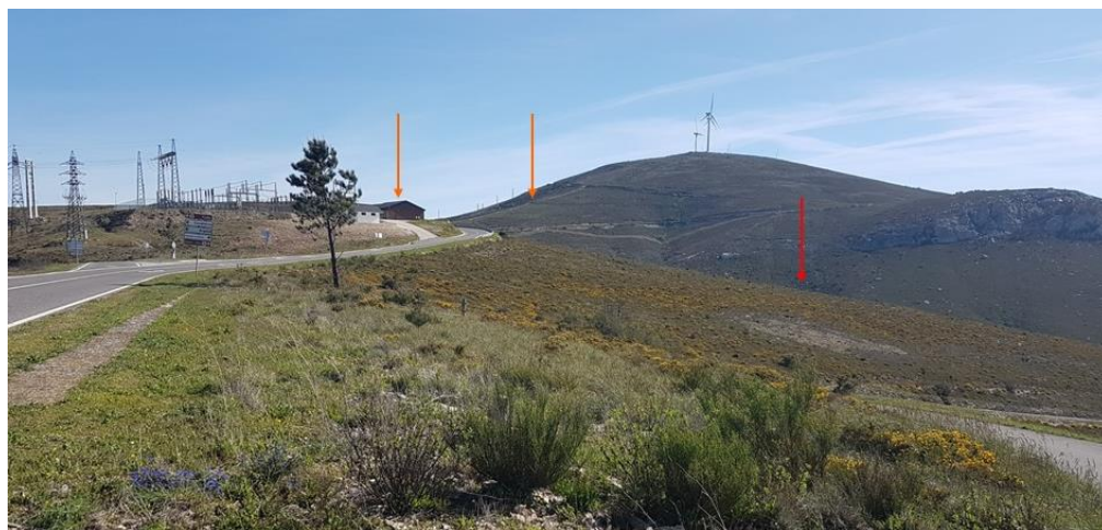
Fotografia 5.1 – Área de intervenção vista de poente (Lomba de Ceiroço) com aerogerador 1 assinalado a vermelho e aerogeradores 2 e 3 a laranja, sendo visíveis os aerogeradores que se estendem na cumeadas até ao vértice de Arouca.
