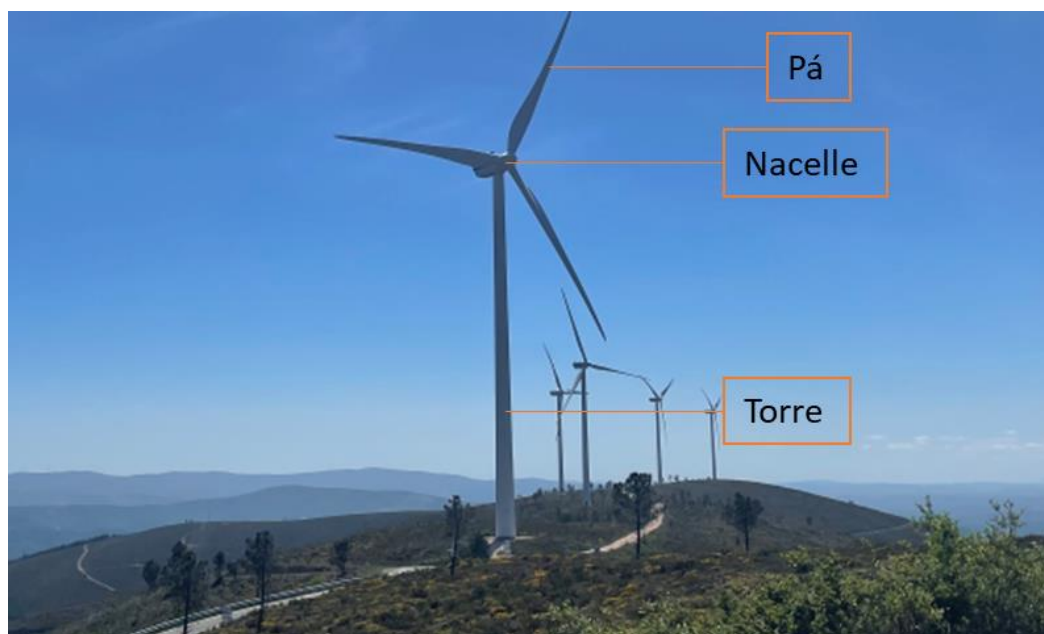
Figura 2.17 - Constituição principal de um aerogerador.
