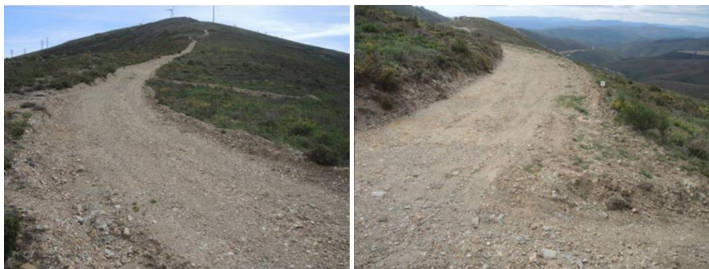
Fotografia 4.16 - Topo onde se irá implantar o AEG 41, onde já existe uma faixa de terreno desmatado e acesso ao atual parque eólico.
