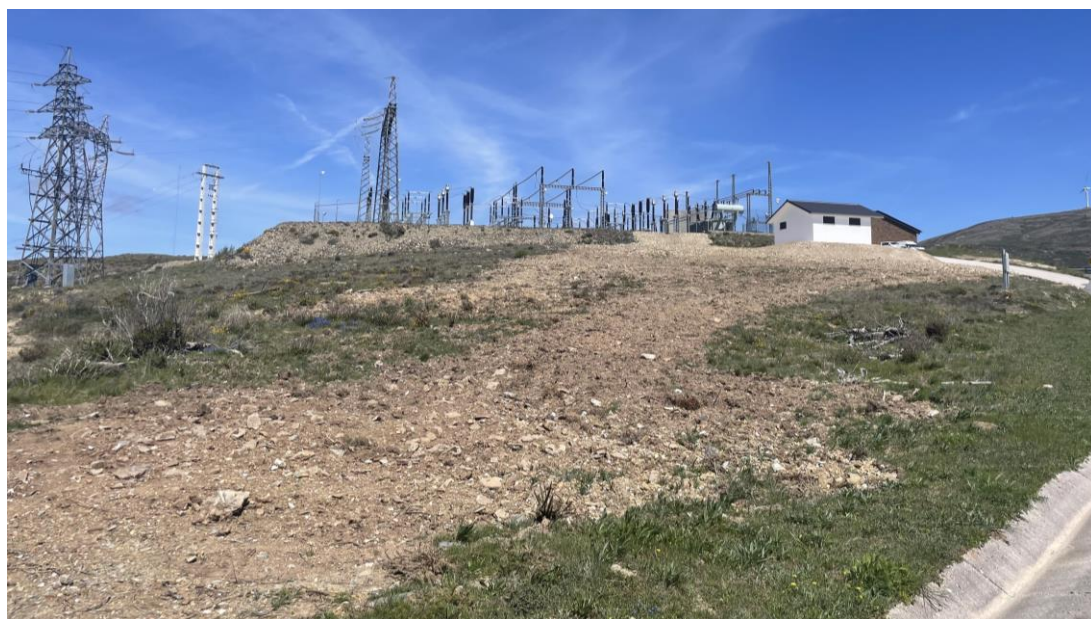
Fotografia 2.3 - Localização do Estaleiro na área de estudo
