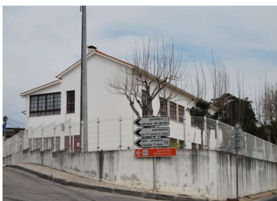
Figura 7.63 – Escola Primária do Souto da Carpalhosa
