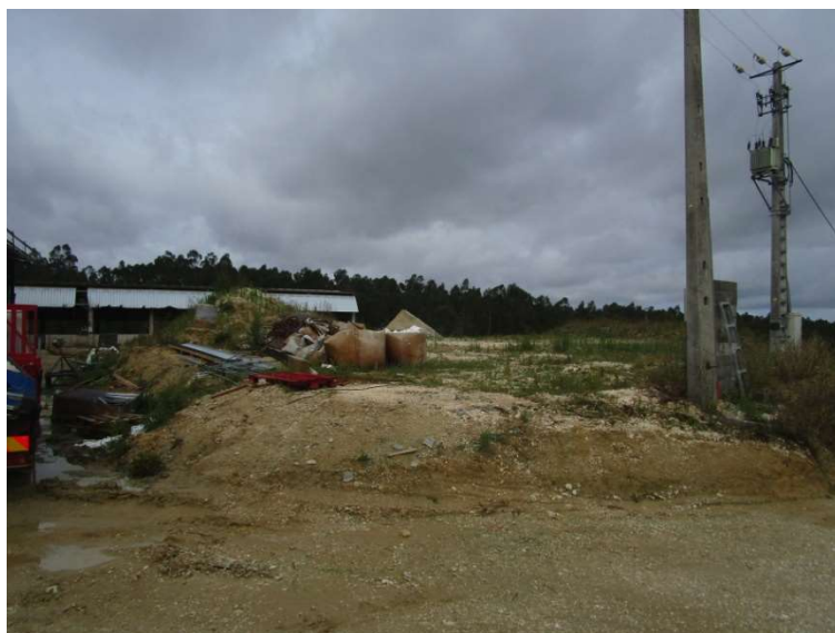
Figura 7.57 – Vista geral do terreno onde arderam 2 pavilhões (solo artificializado)
