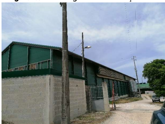
Figura 6.3 - Vista para o Pavilhão 1
