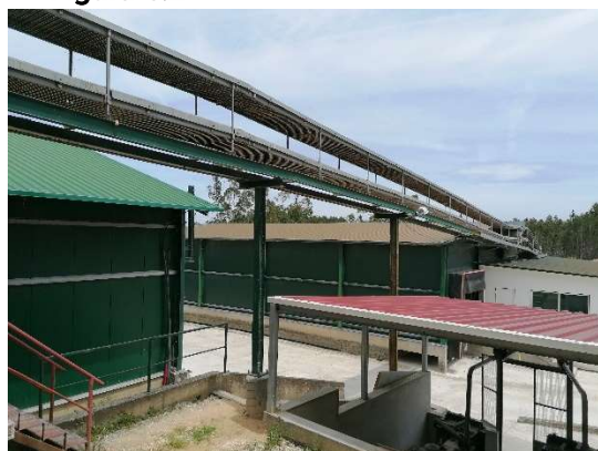
Figura 6.4 - Vista para passadeiras de ovos
