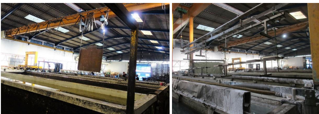
Fotografia 3 - Pormenor da linha de tratamento L5.
