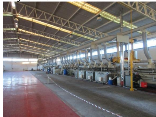
Fotografia 9 - Vista da linha de tratamento L6 antes da instalação da linha de tratamento L7.
