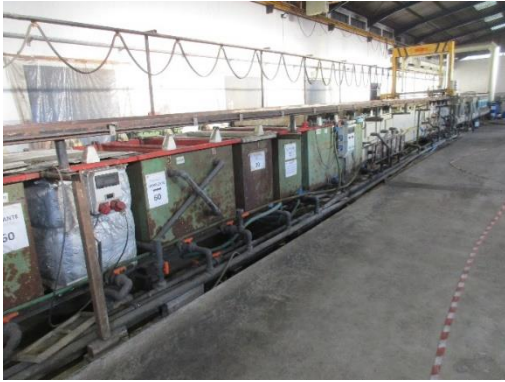
Fotografia 4 - Pormenor da linha de tratamento L2.
