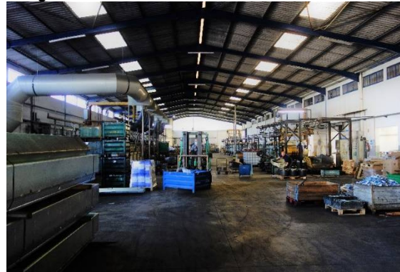
Fotografia 7 - Vista das linhas de tratamento L4 e L3.
