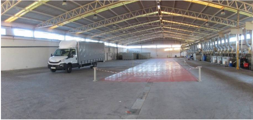
Fotografia 10 - Vista da área prevista para a implantação da linha de tratamento L8 (antes da montagem da linha de tratamento L7).
