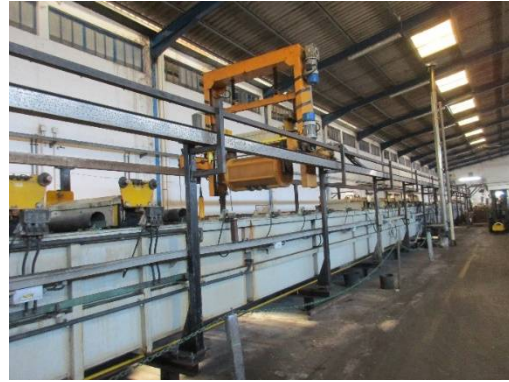
Fotografia 5 - Vista da linha de tratamento L3.
