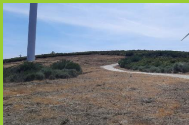
Local do estaleiro
