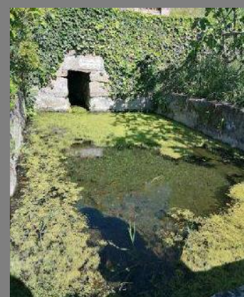
Mina de água presente na área de intervenção
