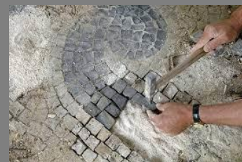
Pavimentação em calçada
