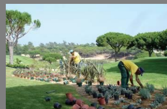
Construção de espaços verdes
