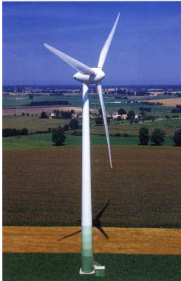
Figura 1 – Exemplo de aerogerador de 1 800 kW (Marca ENERCON, Modelo E66).
