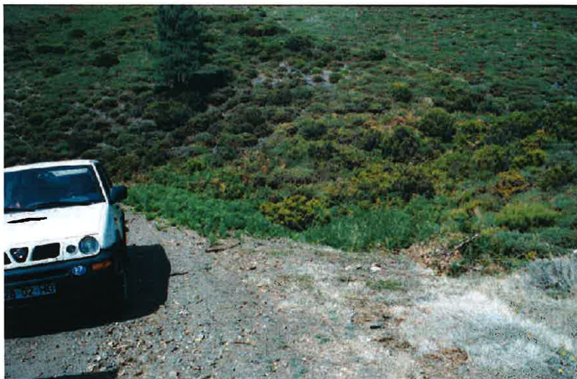
Foto 2 - Cerca 1.5 km do início do acesso principal (Mascoselo/Pigarra) – troço que terá de ser alargado para permitir a passagem das máquinas. Nesta zona (a Norte do acesso) será construído pequeno aterro e uma passagem hidráulica adequada ao regime específico da linha de água atravessada.
