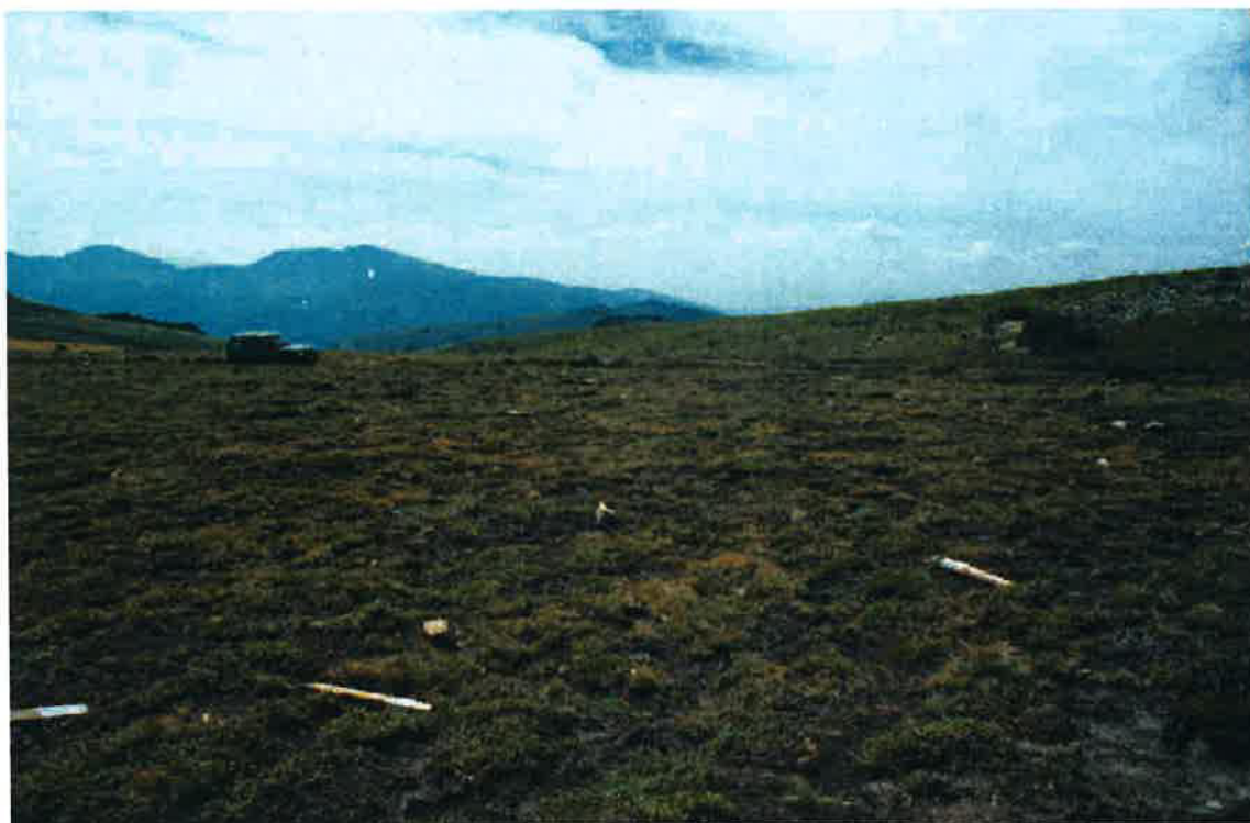
Foto 21 – Local de implantação do aerogerador 9-B. Vista para W. O caminho interno segue da esquerda (Sul) para a direita (Norte), onde está a viatura.
