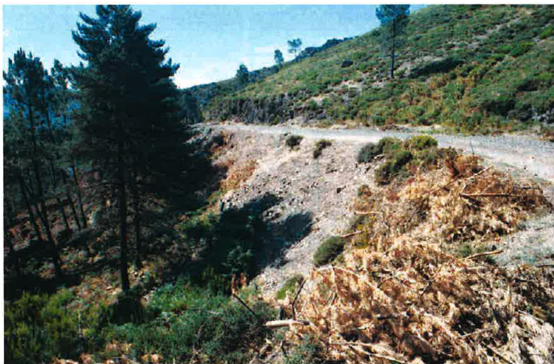
Foto 4 – Zona a Sul do acesso, colocada (pelo PNAL) como hipótese menos desfavorável para construção do aterro previsto para o alargamento do acesso, de modo a permitir a passagem da maquinaria afectada à obra.
