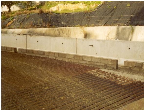
**Figura 4.1 - Exemplo de um Sistema de Lavagem de Rodados (Estaleiro do Metropolitano de Lisboa - Poço de Ataque)**
