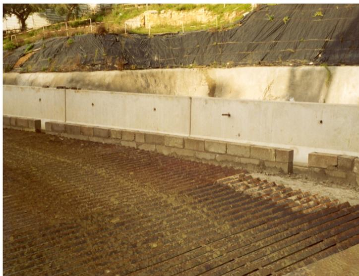
**Figura 5.25 - Exemplo de um Sistema de Lavagem de Rodados (Estaleiro do Metropolitano de Lisboa - Poço de Ataque)**
