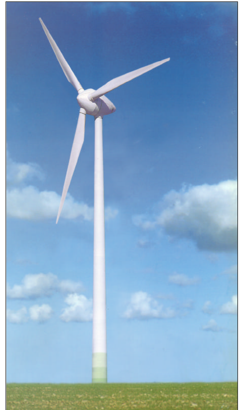
Figura 4 - Aerogerador ENERCON E66/1800 kW
