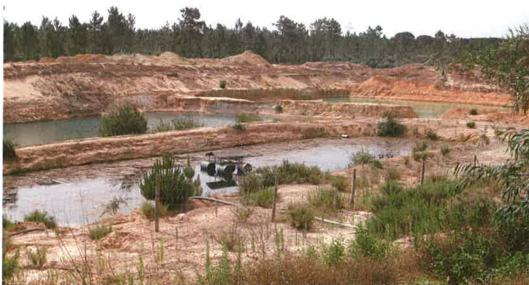
Figura 8– Vista das bacias de decantação do sistema de tratamento de efluentes.
