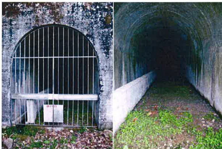
Fotografia 2.1 – Galerias de acesso ao túnel que se desenvolve entre a barragem do Vilar e a central de Tabuaço - sector Nordeste da área A1
