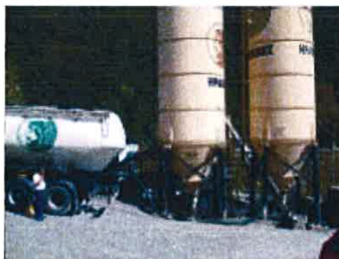
Figura 1.18 – Exemplo de central de Enchimento (EGL/Hellas Gold)
