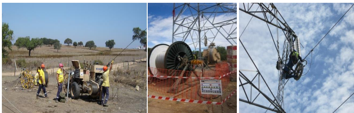
Fotografia 2.3 – Colocação e passagem dos cabos
