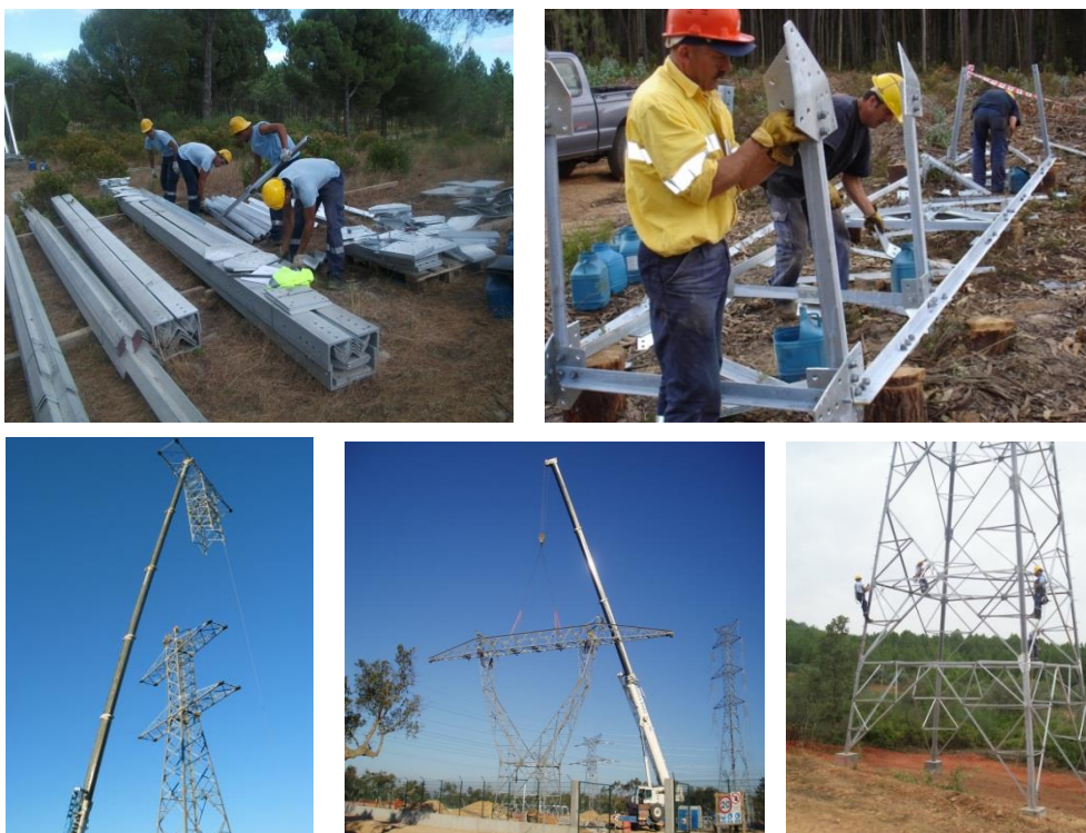
Fotografia 2.2 – Montagem e levantamento dos apoios
