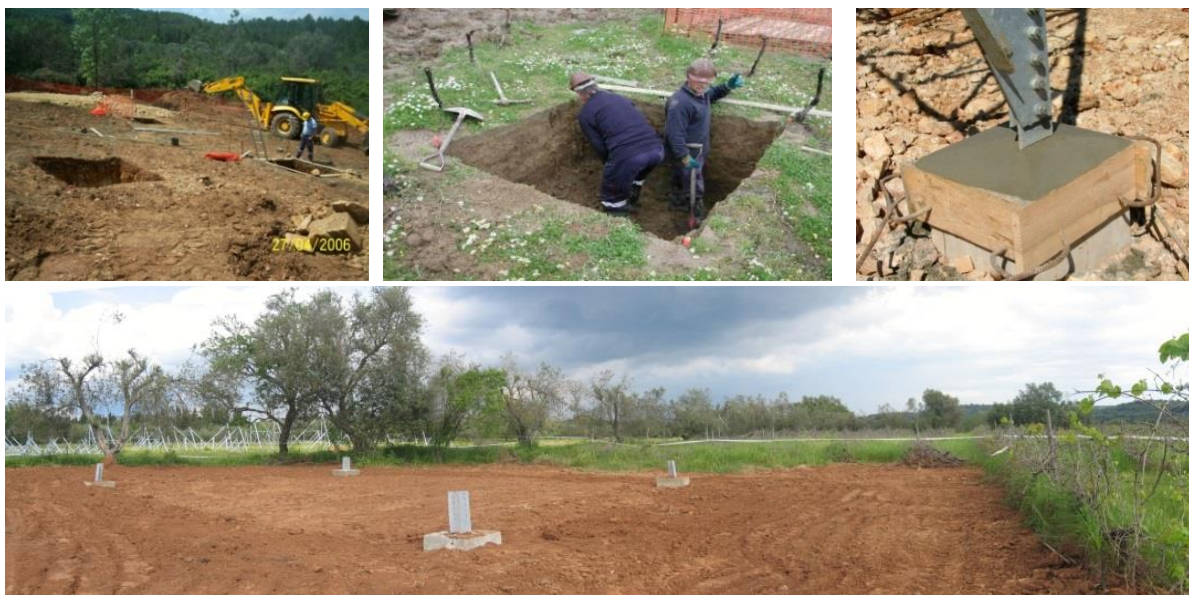
Fotografia 2.1 – Abertura de caboucos e execução das fundações dos apoios da linha
