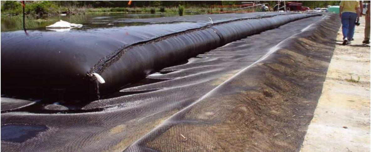
Figura 28– Ilustração dos sacos drenantes a utilizar para os rejeitados finos e com elevado teor de água.
