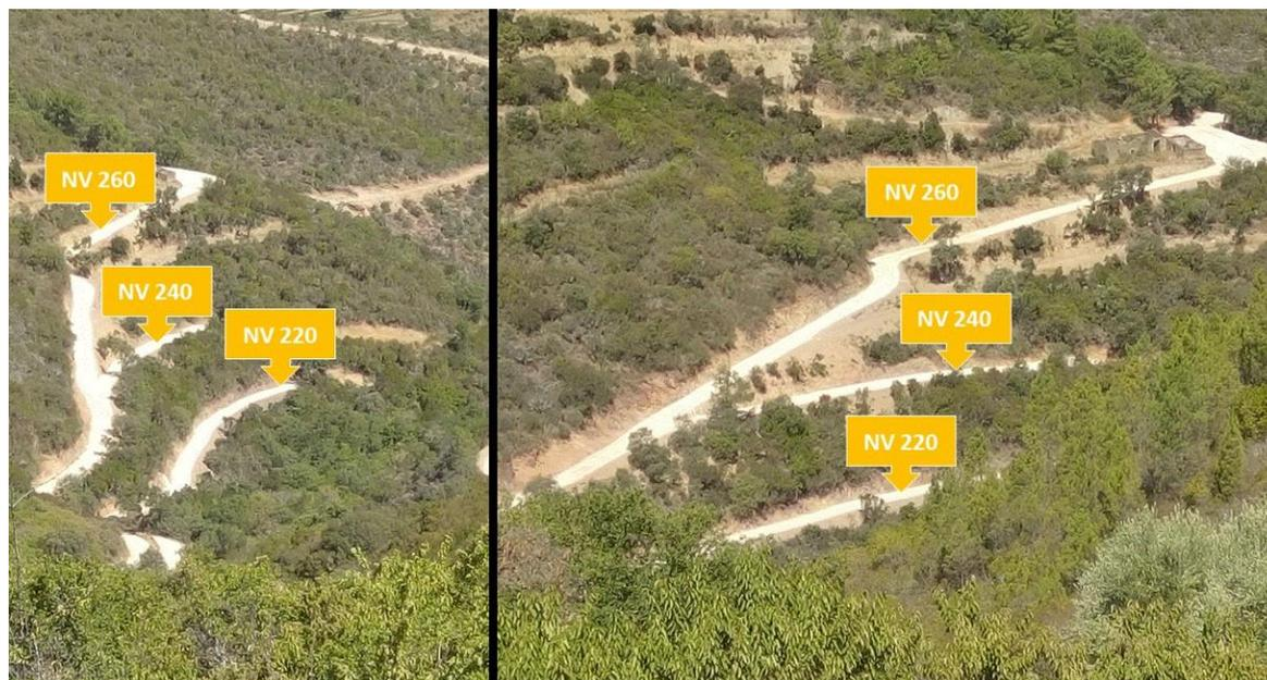
Figura 30 – Localização prevista para os emboquilhamentos das galerias da Mina observando-se os acessos já melhorados
