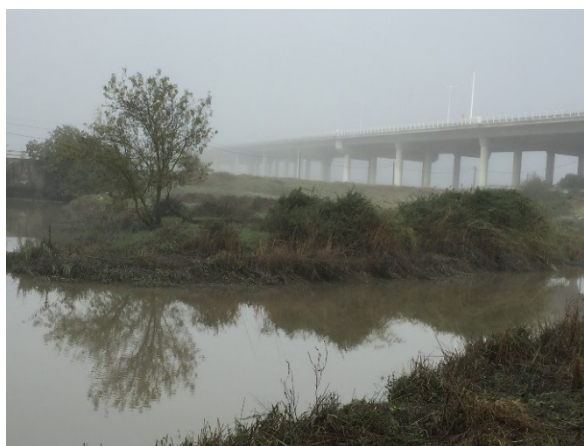
Figura 71 – Linha de água SUP13 (jusante) no período crítico
