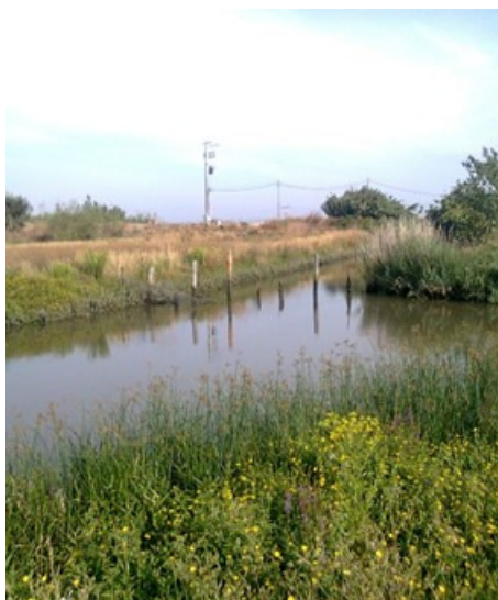
Figura 165 – Zona de confluência da vala dos Arcaus à vala/rio do Risco
