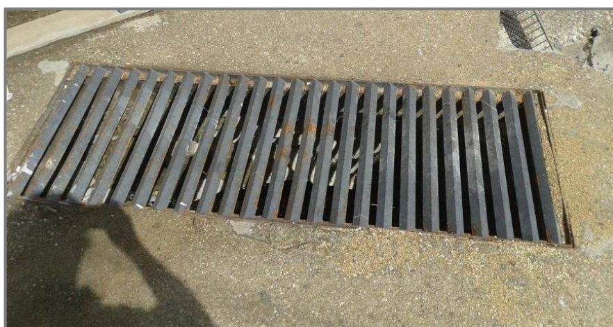
Figura 2 – Ponto de recolha de águas superficiais 1 – PH 2.1 – montante.
