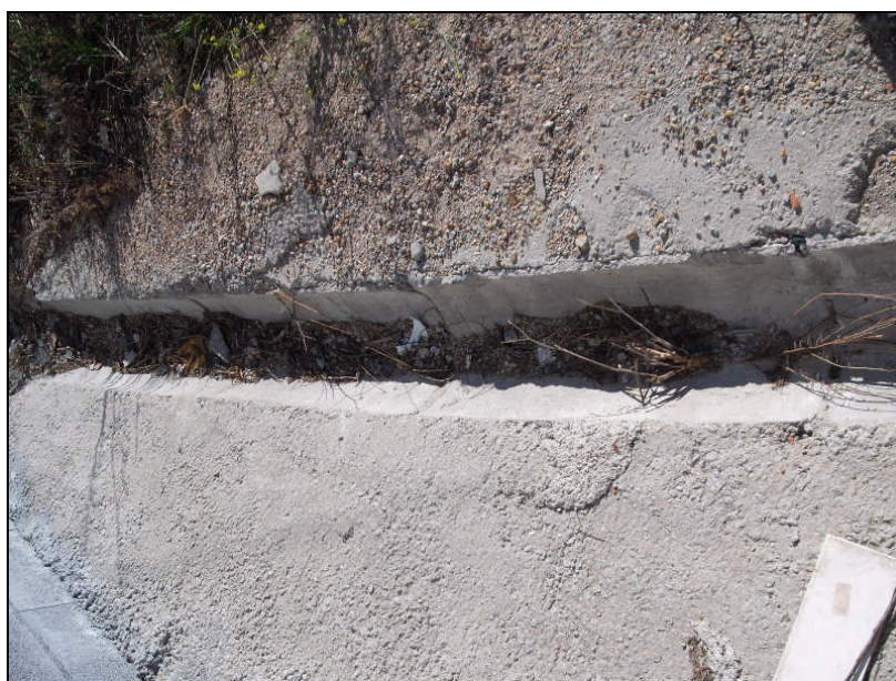
Figura 3.10 – Ponto de recolha 10 – Descarga das escorrências da plataforma na linha de água restabelecida pela PH 2.1.
