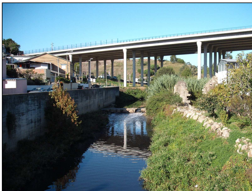
Figura 3.2 – Ponto de recolha 2 – Rio Leça, no ponto imediatamente a jusante da intercepção com o traçado, aproximadamente ao Km 0+275.
