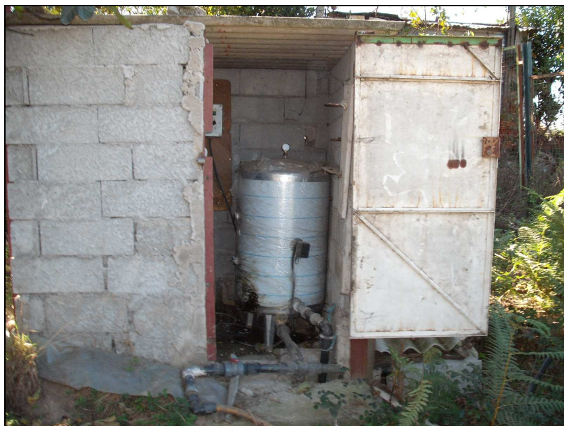
Figura 3.6 – Ponto de recolha 6 – Poço localizado junto à estrada e junto à linha de água restabelecida pela PH 1.3, receptora das escorrências da estrada (B).
