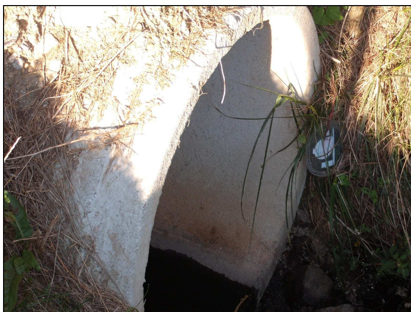
Figura 3.3 – Ponto de recolha 3 – Linha de água interceptada pelo Nó do Aeroporto, no ponto imediatamente a montante da intercepção com o traçado.
