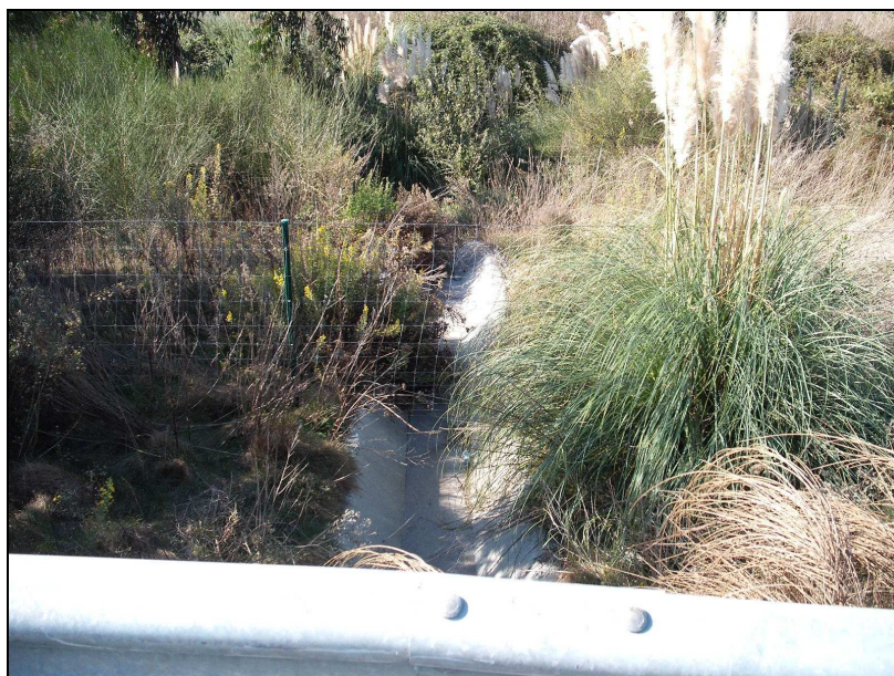
Figura 3.8 – Ponto de recolha 8 – descargas das escorrências da plataforma na linha de água interceptada pelo Nó do Aeroporto.
