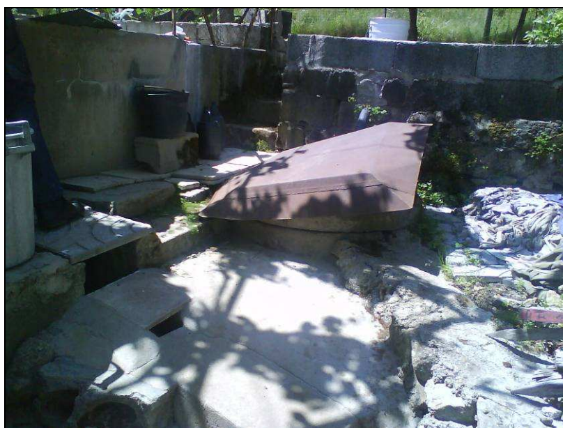
Figura 3.9 – Ponto de recolha 11 – Poço ao Km 1+875, lado Sul da via.
