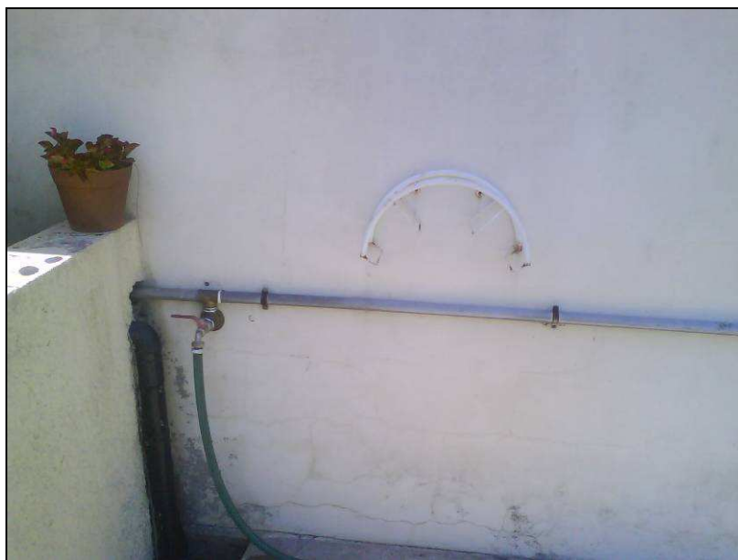
Figura 3.10 – Ponto de recolha 13 – Furo ao Km 2+340, lado Oeste da via.
