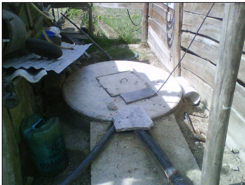
Figura 3.16 – Ponto de recolha 18 – Poço a Norte do Ramo D do Nó de Lousada.
