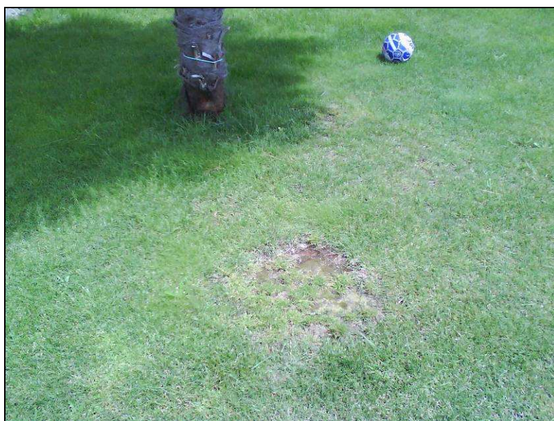
Figura 3.11 – Ponto de recolha 14 – Poço ao Km 3+175, lado Sul da via.
