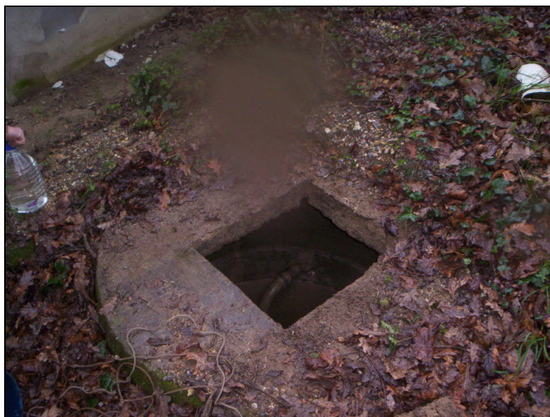
Figura 3.13 – Ponto de recolha 13 – Poço ao Km 13+380.
