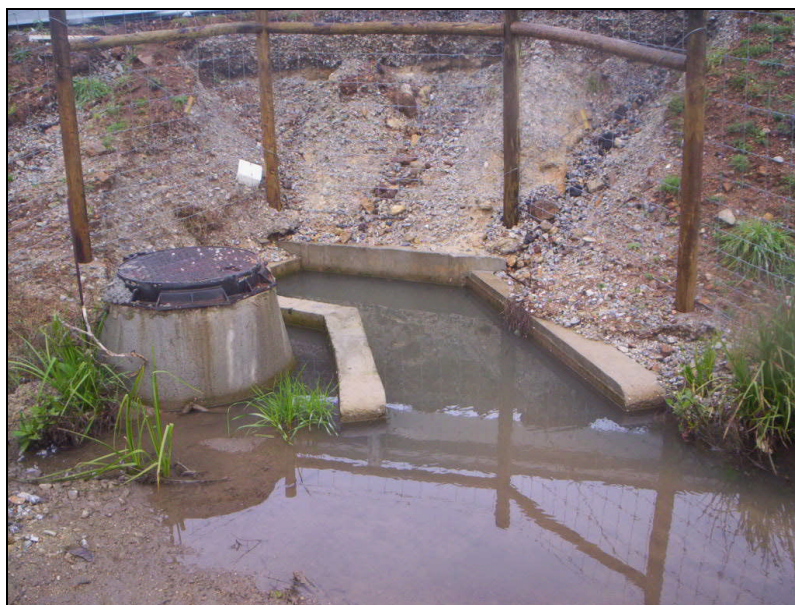
Figura 3.7 – Ponto de recolha 7 – Jusante da PH 10.1 (PK 10+200).
