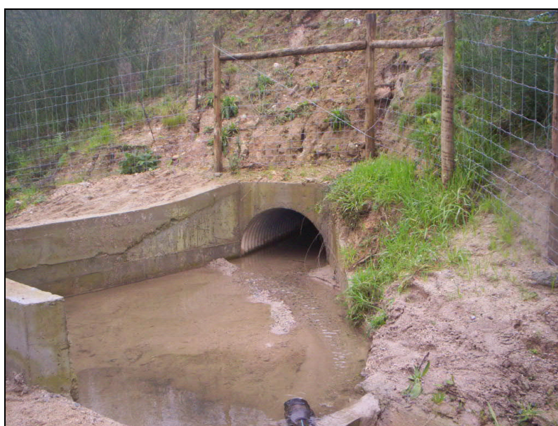
Figura 3.8 – Ponto de recolha 8 – Jusante da PH 10.2 (PK 10+608).
