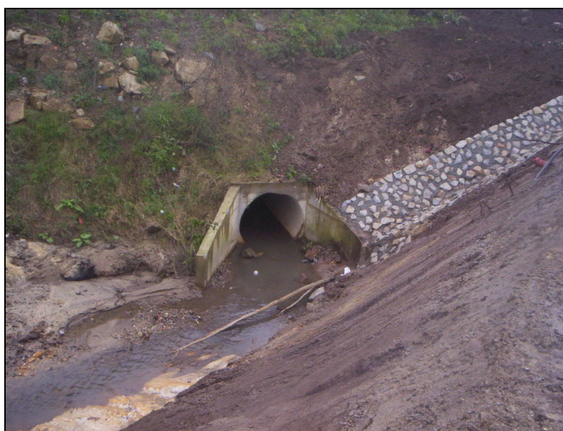
Figura 3.4 – Ponto de recolha 4 – Jusante da PH 2.3 (PK 2+950).
