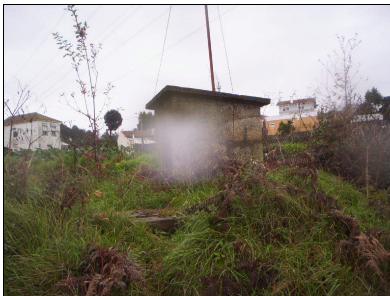
Figura 3.12 – Ponto de recolha 12 – Poço ao Km 11+000.
