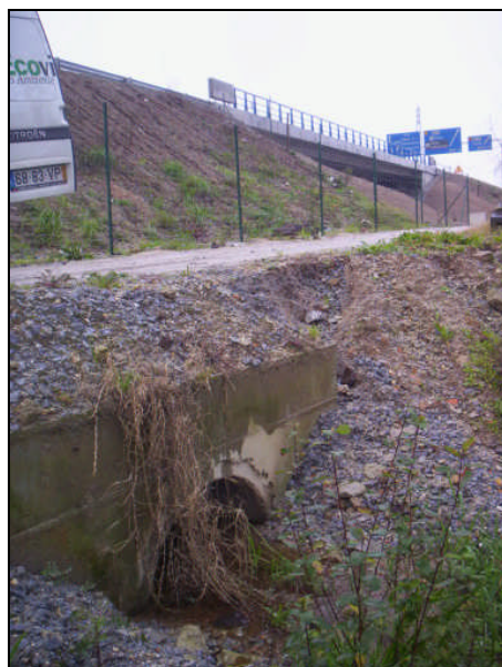
Figura 3.5 – Ponto de recolha 5 – Jusante da PH 8.2 (PK 8+607).
