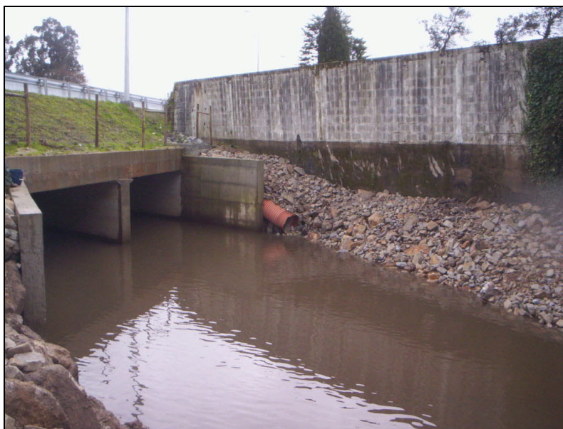
Figura 3.1 – Ponto de recolha 1 – Ribeira do Arquinho, ao Km 9+599, imediatamente a jusante da estrada.
