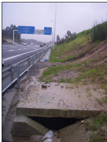
Figura 3.3 – Ponto de recolha 3 – Jusante da PH 1.1 (PK 1+803).
