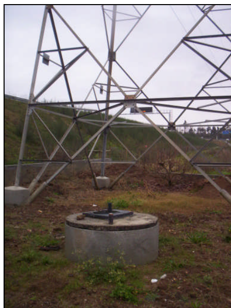
Figura 3.11 – Ponto de recolha 11 – Poço ao Km 10+780.
