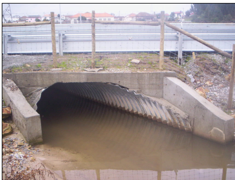
Figura 3.6 – Ponto de recolha 6 – Jusante da PH 9.1 (PK 9+087).
