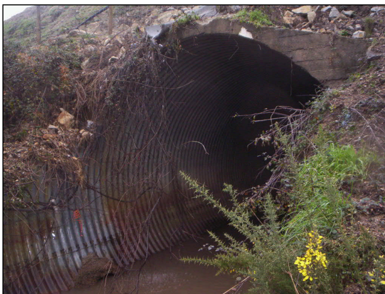
Figura 3.37 – Ponto de recolha 2 – Ribeira do Leandro, ao Km 12+959, imediatamente a jusante da estrada.
