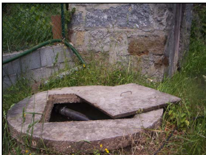
Figura 3.12 – Ponto de recolha 12 – Poço junto ao Viaduto 3.
