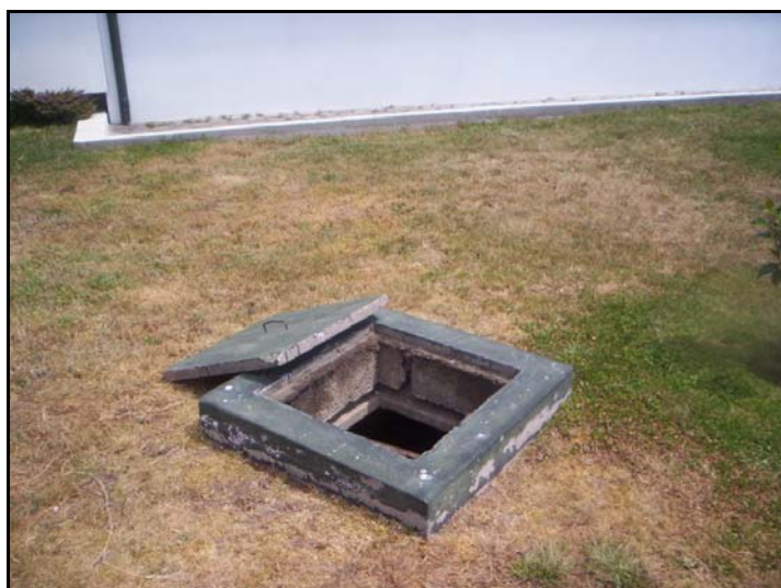
Figura 3.26 – Ponto de recolha 12 – Poço junto ao Nó de Paços de Ferreira.
