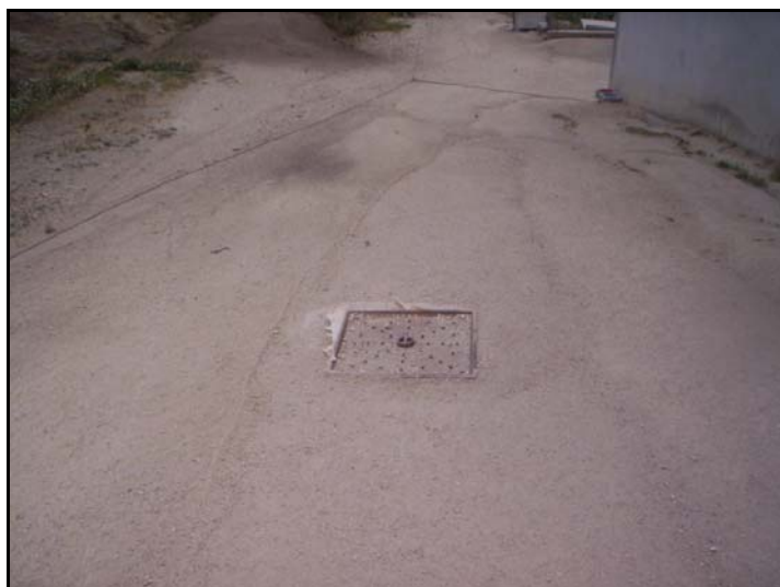
Figura 3.25 – Ponto de recolha 11 – Furo junto ao Km 5+225.
