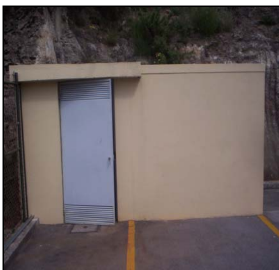
Figura 3.24 – Ponto de recolha 10 – Furo licenciado pela DRA – Norte, junto ao Km 4+000.
