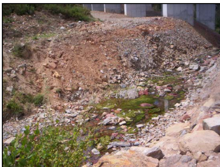
Figura 3.8 – Ponto de recolha 8 – Jusante do Viaduto 3, sobre a Ribeira de Ermida, a cerca de 30 a 60 m do local da descarga das águas de escorrência.
