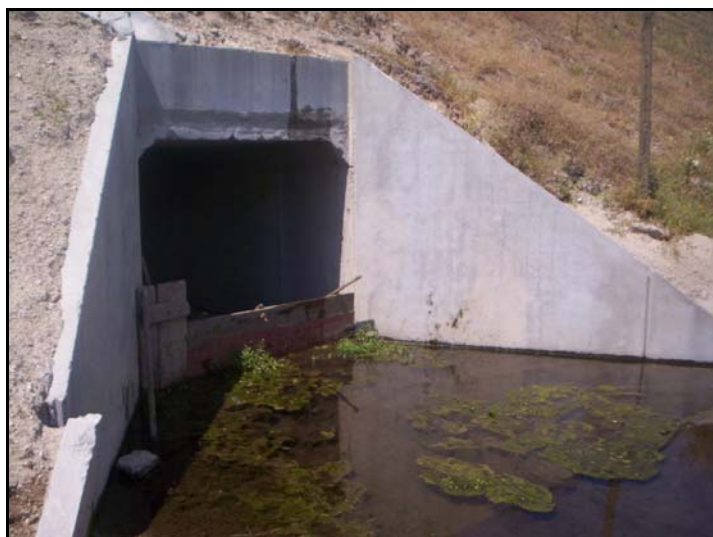
Figura 3.21 – Ponto de recolha 7 – Montante da linha de água restabelecida pela PH 6.2.
