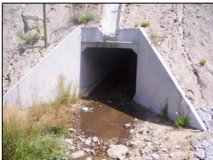
Figura 3.22 – Ponto de recolha 8 – Jusante da linha de água restabelecida pela PH 6.2.
