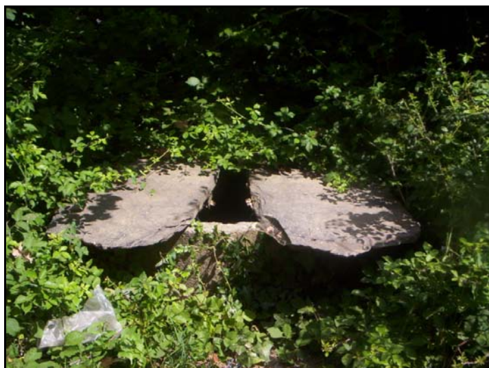
Figura 3.9 – Ponto de recolha 9 – Poço junto ao Viaduto 1.
