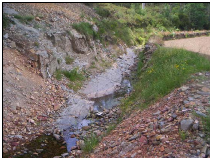
Figura 3.7 – Ponto de recolha 7 – Montante do Viaduto 3, sobre a Ribeira de Ermida.
