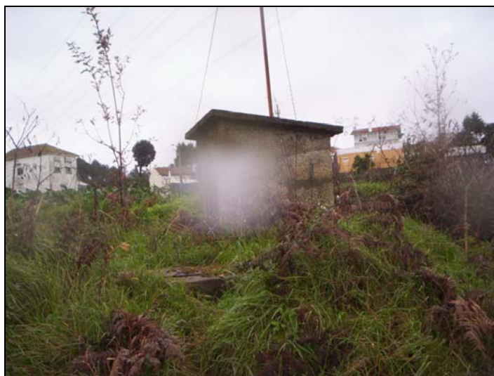
Figura 3.47 – Ponto de recolha 12 – Poço ao Km 11+000.
