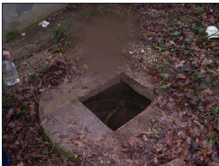
Figura 3.48 – Ponto de recolha 13 – Poço ao Km 13+380.
