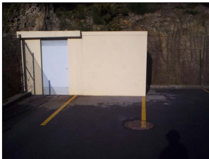
Figura 3.23 – Ponto de recolha 10 – Furo licenciado pela DRA – Norte, junto ao Km 4+000.
