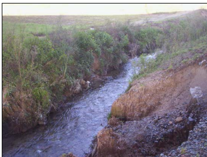
Figura 3.16 – Ponto de recolha 3 – Montante do afluente do Ribeiro de Feteira, restabelecido pelo Viaduto 1.
