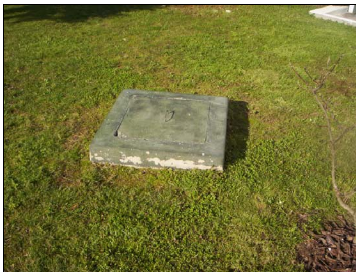
Figura 3.25 – Ponto de recolha 12 – Poço junto ao Nó de Paços de Ferreira.
