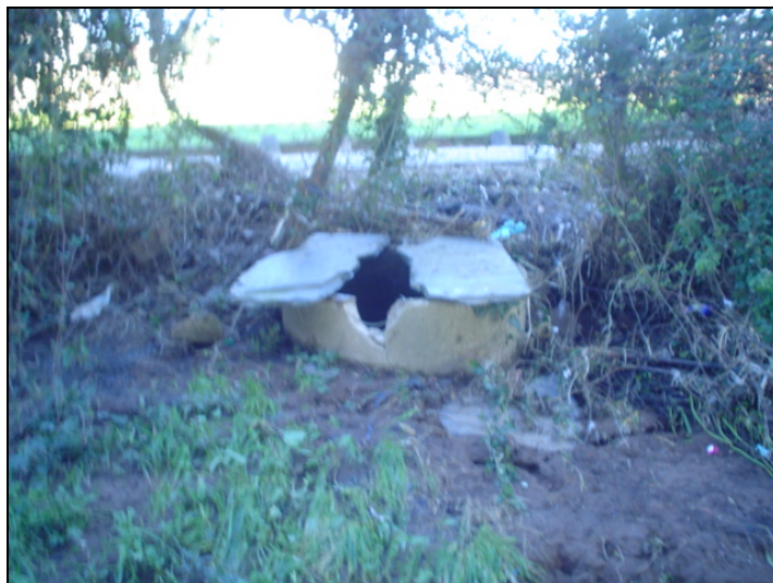
Figura 3.9 – Ponto de recolha 9 – Poço junto ao Viaduto 1.
