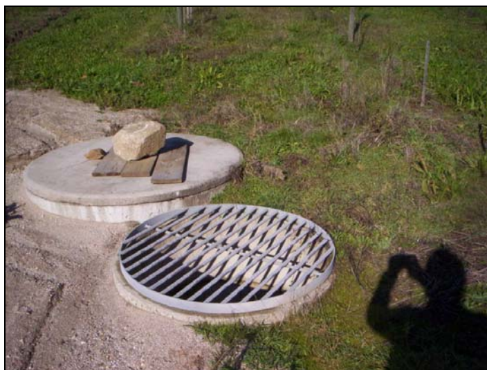
Figura 3.33 – Ponto de recolha 7 – Mina ao Km 3+800.
