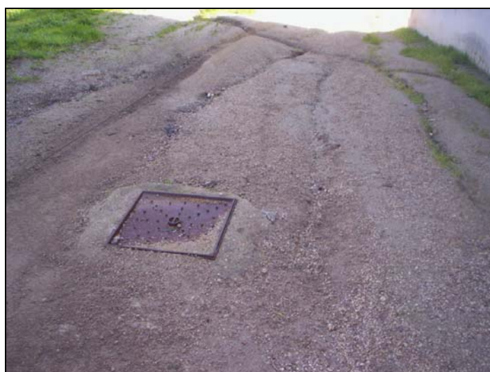
Figura 3.24 – Ponto de recolha 11 – Furo junto ao Km 5+225.
