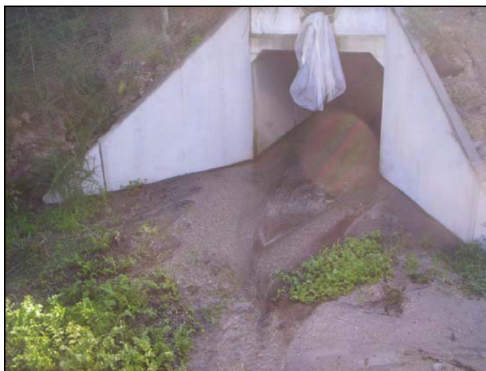
Figura 3.21 – Ponto de recolha 8 – Jusante da linha de água restabelecida pela PH 6.2.
