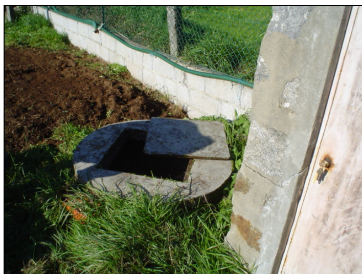
Figura 3.12 – Ponto de recolha 12 – Poço junto ao Viaduto 3.
