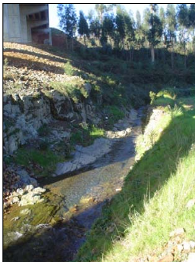
Figura 3.7 – Ponto de recolha 7 – Montante do Viaduto 3, sobre a Ribeira de Ermida.
