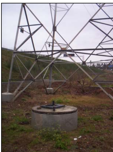
Figura 3.46 – Ponto de recolha 11 – Poço ao Km 10+780.
