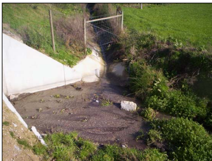
Figura 3.20 – Ponto de recolha 7 – Montante da linha de água restabelecida pela PH 6.2.
