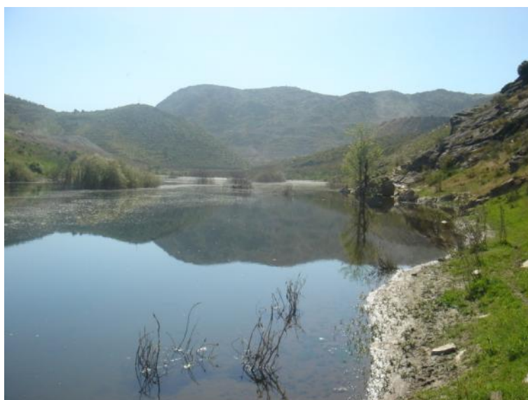
PANORÂMICA DO LOCAL L7 – ZONA DE OBRA DO ESCALÃO DE MONTANTE
