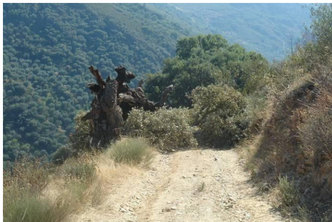
OBSTRUÇÃO DO CAMINHO DE ACESSO AO LOCAL C11 – PARADINHA NOVA EM OUTONO DE 2011
