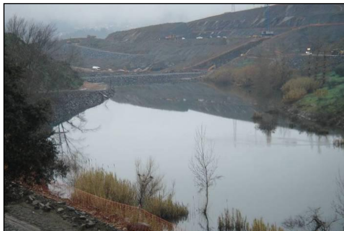
PANORÂMICA DO LOCAL L4 – ZONA DE OBRA DO ESCALÃO DE JUSANTE, ONDE SE NOTA O AUMENTO DO NÍVEL DAS ÁGUAS E CONSEQUENTE SUPRESSÃO DE MARGENS PROSPECTÁVEIS, NO INVERNO DE 2011
