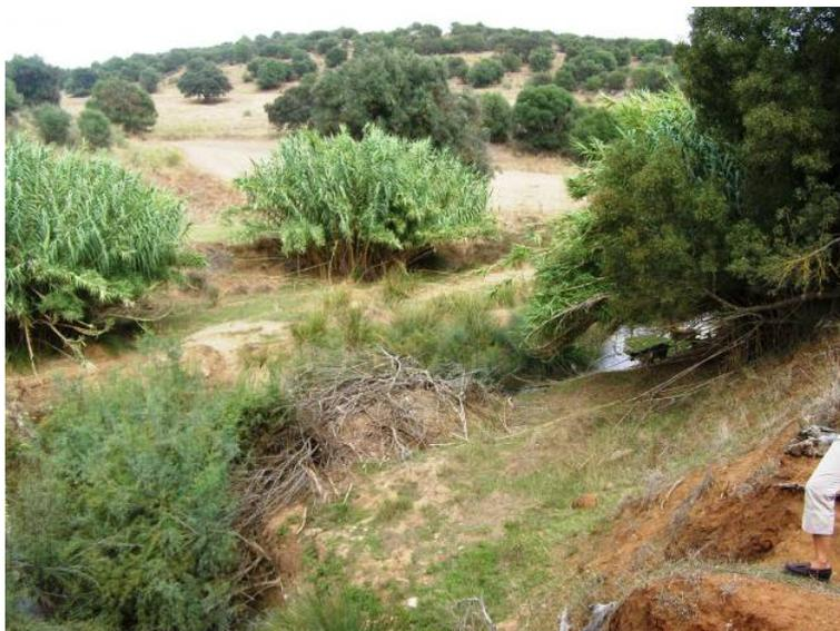
**Imagem Justificação das soluções técnicas desenvolvidas no projecto.13 – Talude na margem esquerda, com problemas de erosão, a jusante do moinho**
