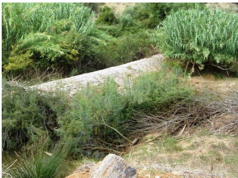
**Imagem Justificação das soluções técnicas desenvolvidas no projecto.11 – Açude “rebentado”**
