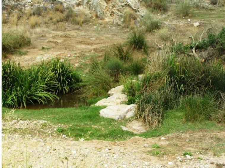
**Imagem Justificação das soluções técnicas desenvolvidas no projecto.9 – Pedras colocadas no leito que funcionam como “açude”**
