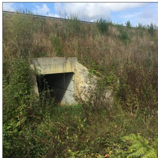
**Figura 3 – S1J - Linha de água restituída pela PH 4.1, a jusante da via**
