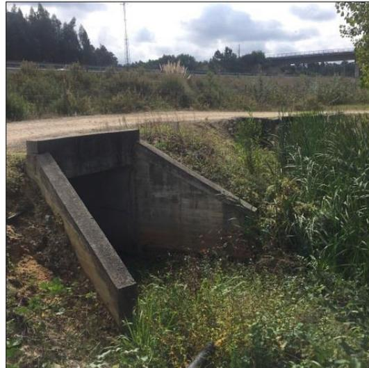
**Figura 2 – S1M - Linha de água restituída pela PH 4.1, a montante da via.**
