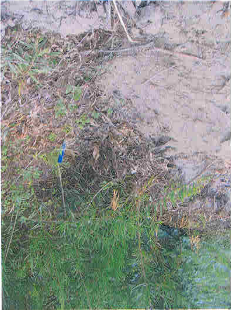
Figura 15 - Ribeira do Boqueirão Pk 5+774
