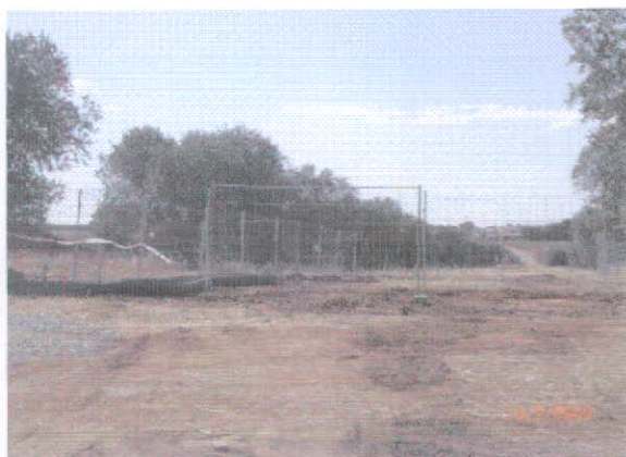
P3: Estaleiro de Apoio do Reservatório dos Montinhos – Situação Inicial
