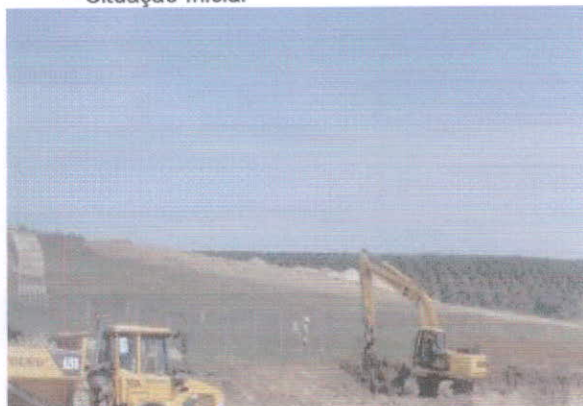
P5: Estaleiro de Apoio da Estação Elevatória da Laje – Situação Inicial
