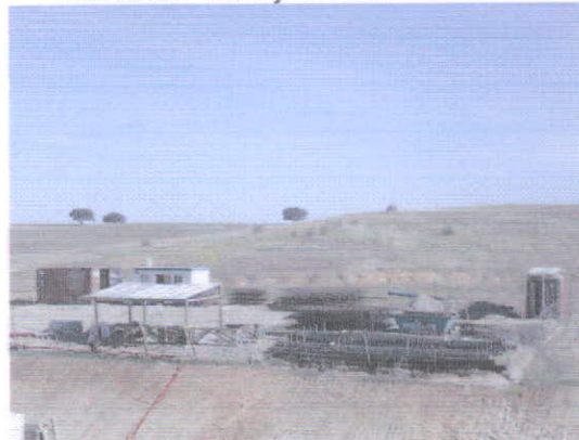
P6: Estaleiro de Apoio da Estação Elevatória da Laje – Situação Actual
