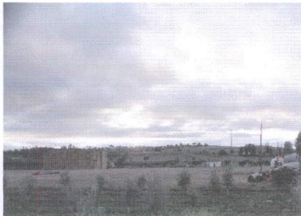
P1: Estaleiro Central - Situação Inicial
