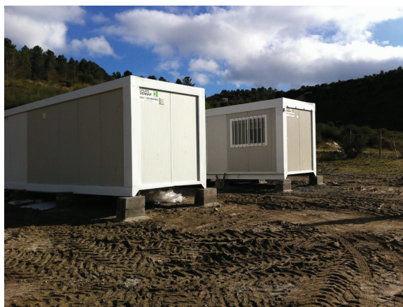
Registo Fotográfico 2 – Montagem contentores
