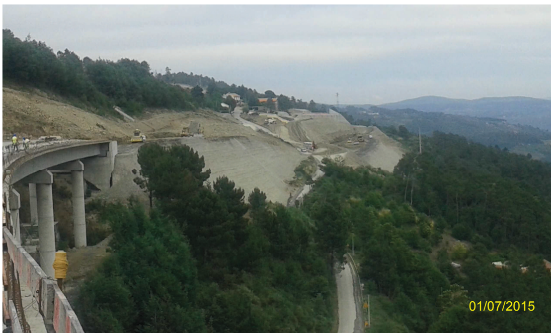
Registo Fotográfico 1 – Execução de Muro em Solo-cimento do Muro M40 (Pk 20+200)
