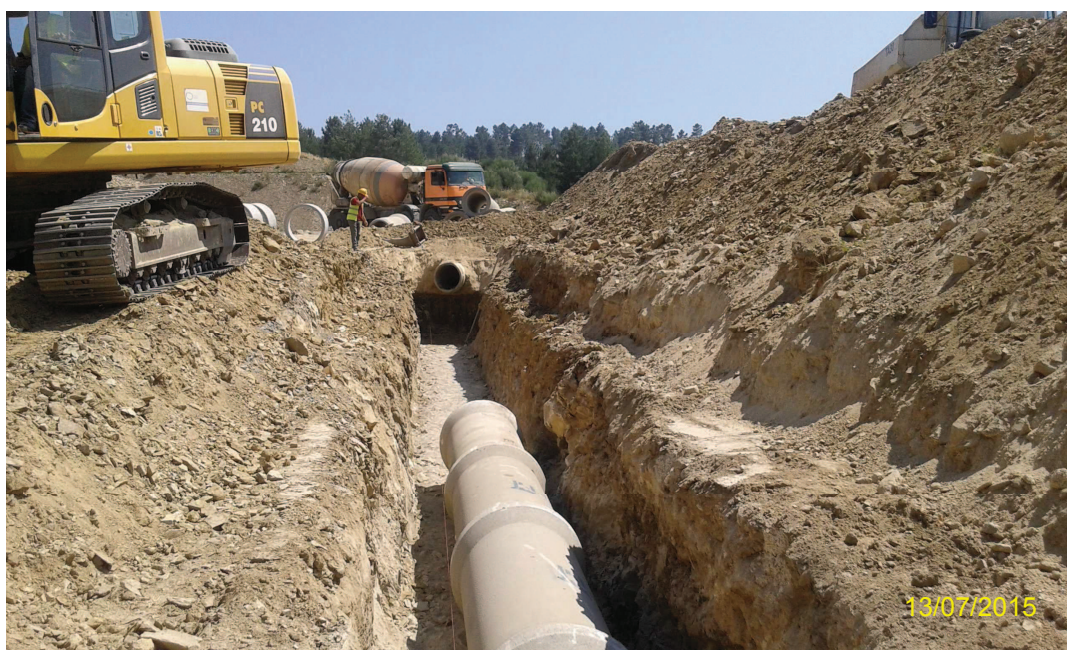
Registo Fotográfico 3 – Trabalhos de Drenagens junto ao Pk 23+050
