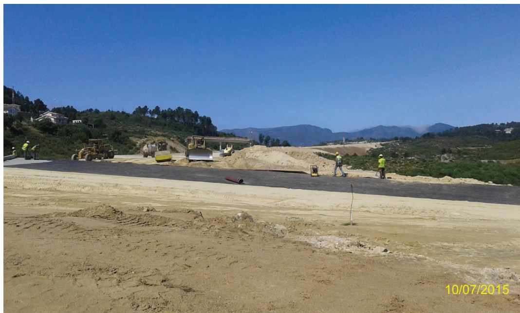
Registo Fotográfico 2 – Trabalhos de escavação junto à PA8 (Pk 27+200)
