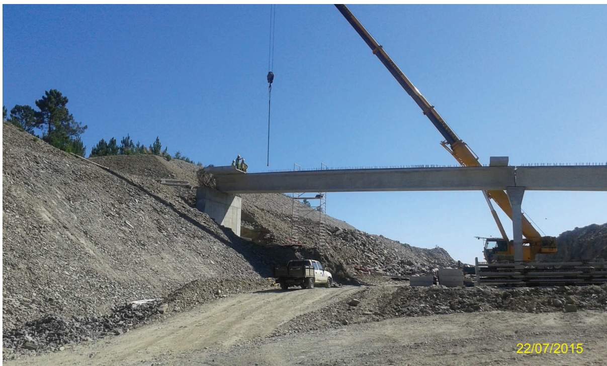
Registo Fotográfico 6 – Montagem de pré-lajes (PS9), junto ao Pk 20+900
