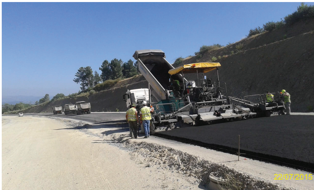
Registo Fotográfico 4 – Pavimentação junto ao Pk 24+200
