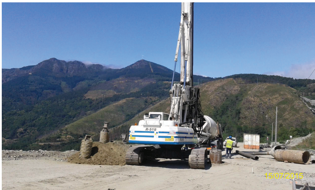
Registo Fotográfico 7 – Execução de estacas (PI7B), junto ao Pk 20+255
