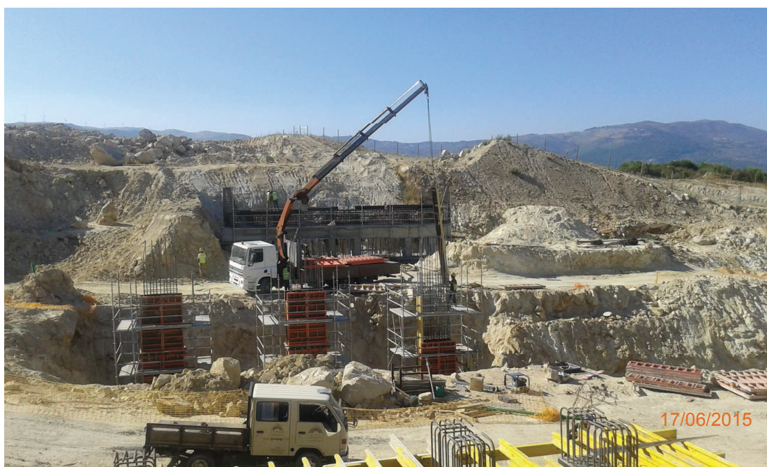
Registo Fotográfico 8 – Execução de Pilares e Viga Estribo (PS11A), junto ao Pk 29+300
