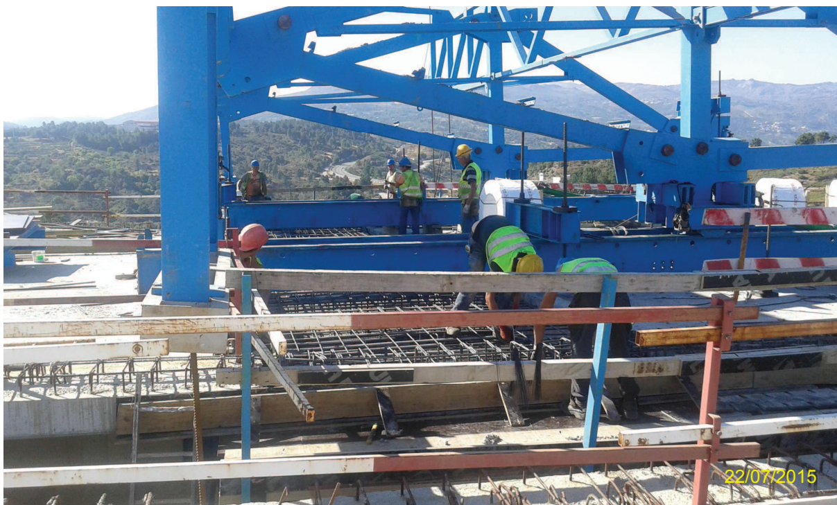
Registo Fotográfico 5 – Betonagem de Fecho de Tabuleiro (Viaduto V12), junto ao Pk 27+600
