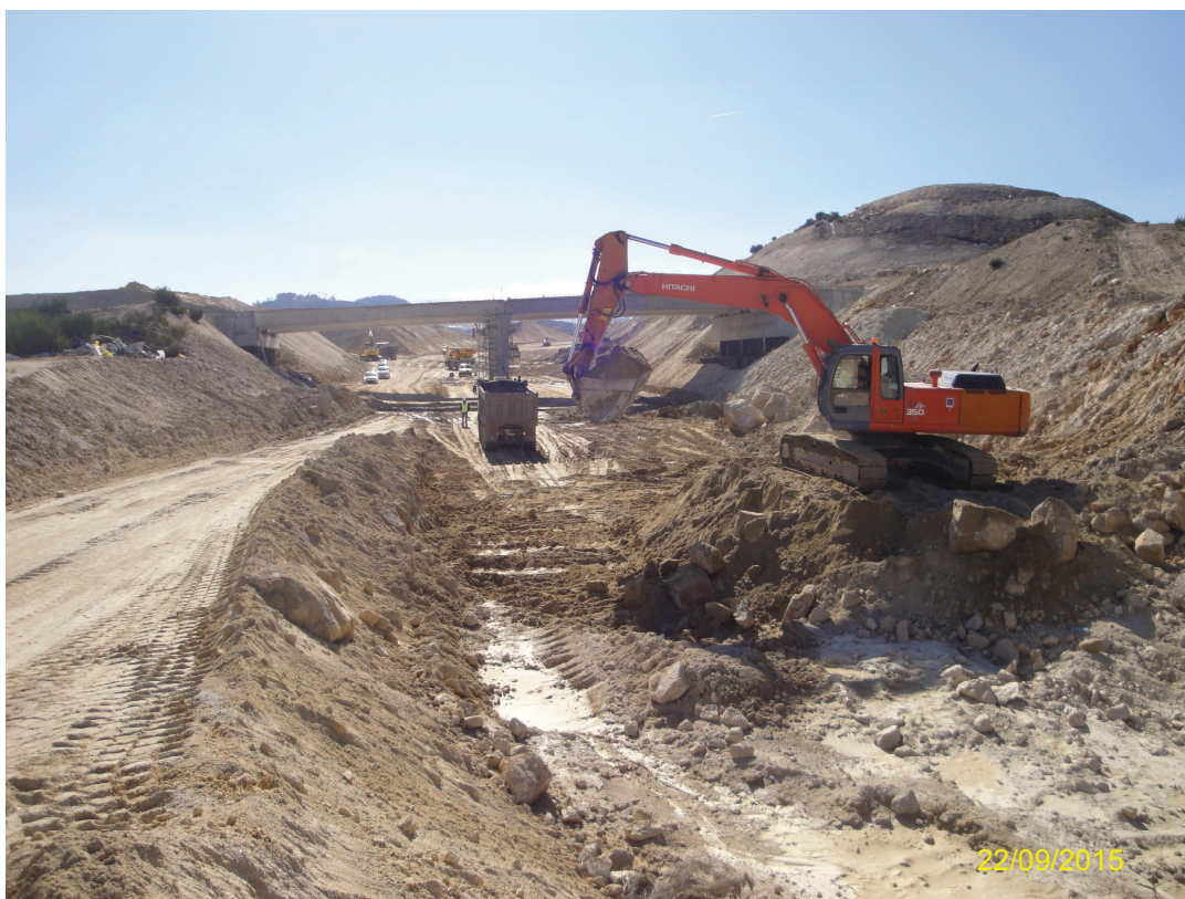
Registo Fotográfico 1 – Execução de Escavação (Pk 29+400)
