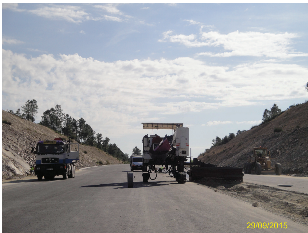
Registo Fotográfico 5 – Execução de valeta de plataforma junto ao Pk 23+400
