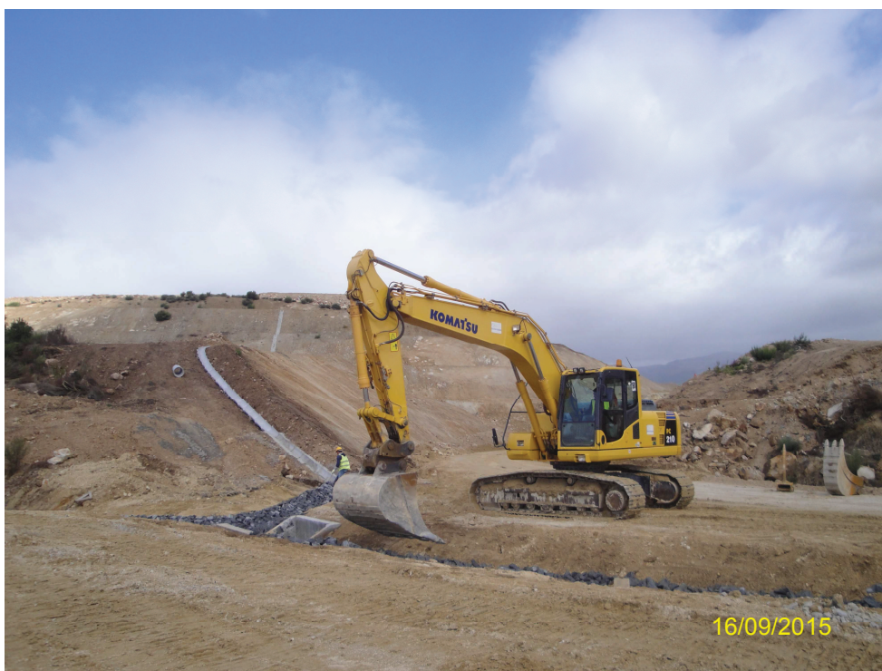
Registo Fotográfico 4 – Execução de drenos junto ao Pk 29+050
