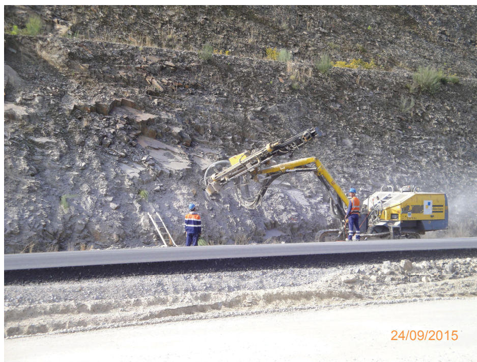
Registo Fotográfico 6 – Execução de pregagens junto ao Pk 22+200
