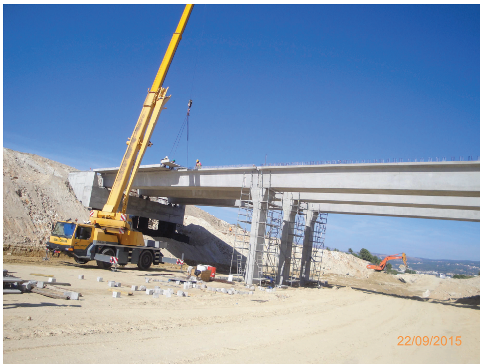
Registo Fotográfico 7 – Montagem de pré fabricados (PS11A), junto ao Pk Pk 29+300
