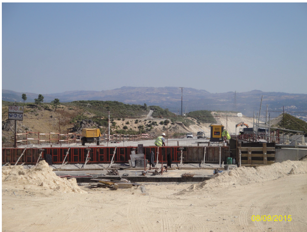
Registo Fotográfico 8 – Execução de Encontros (Viaduto V12), junto ao Pk 27+600
