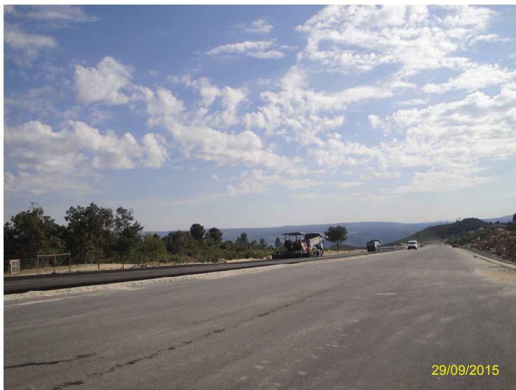
Registo Fotográfico 3 – Trabalhos de Pavimentação ao Pk 26+000
