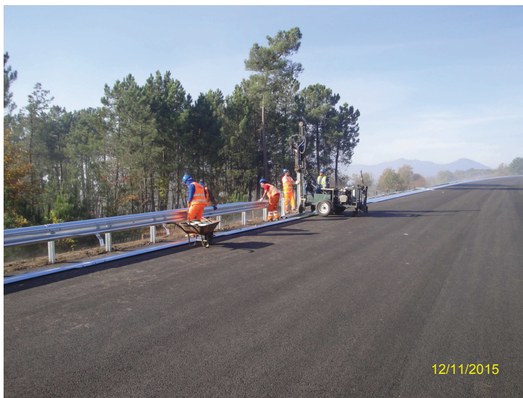
Registo Fotográfico 4 – Execução de guardas de segurança junto ao Pk 22+900
