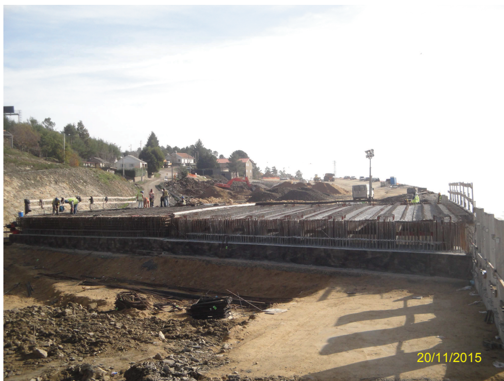
Registo Fotográfico 8 – Execução de Tabuleiro (PI7B), junto ao Pk 20+255
