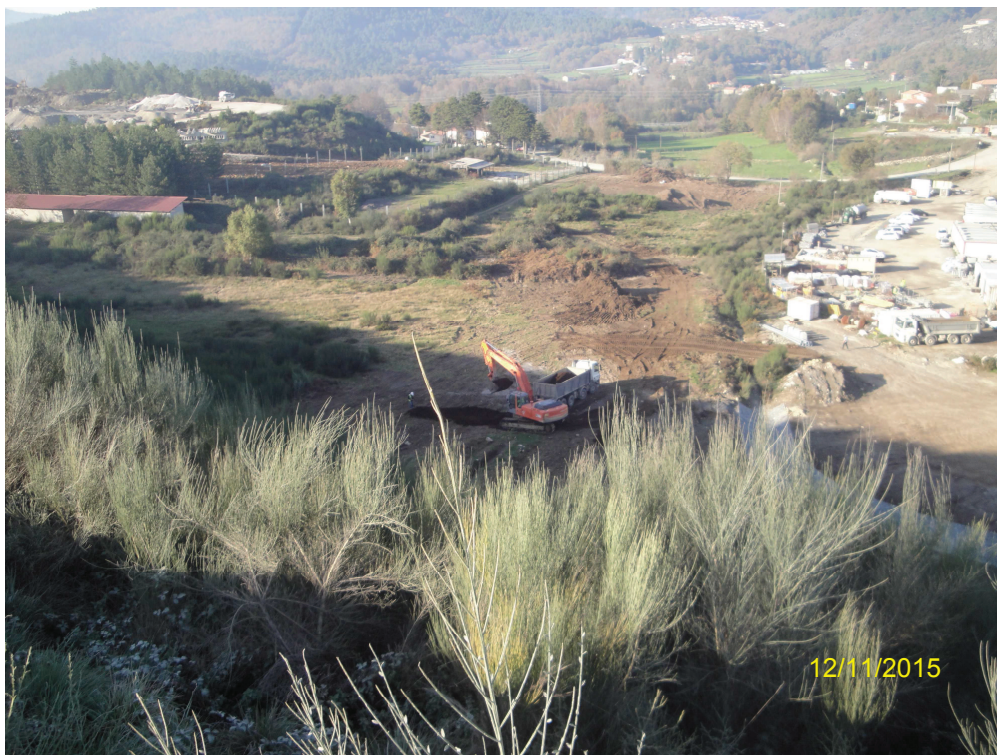
Registo Fotográfico 1 – Execução de Sistemas de Tratamento e Retenção (Pk 22+900)
