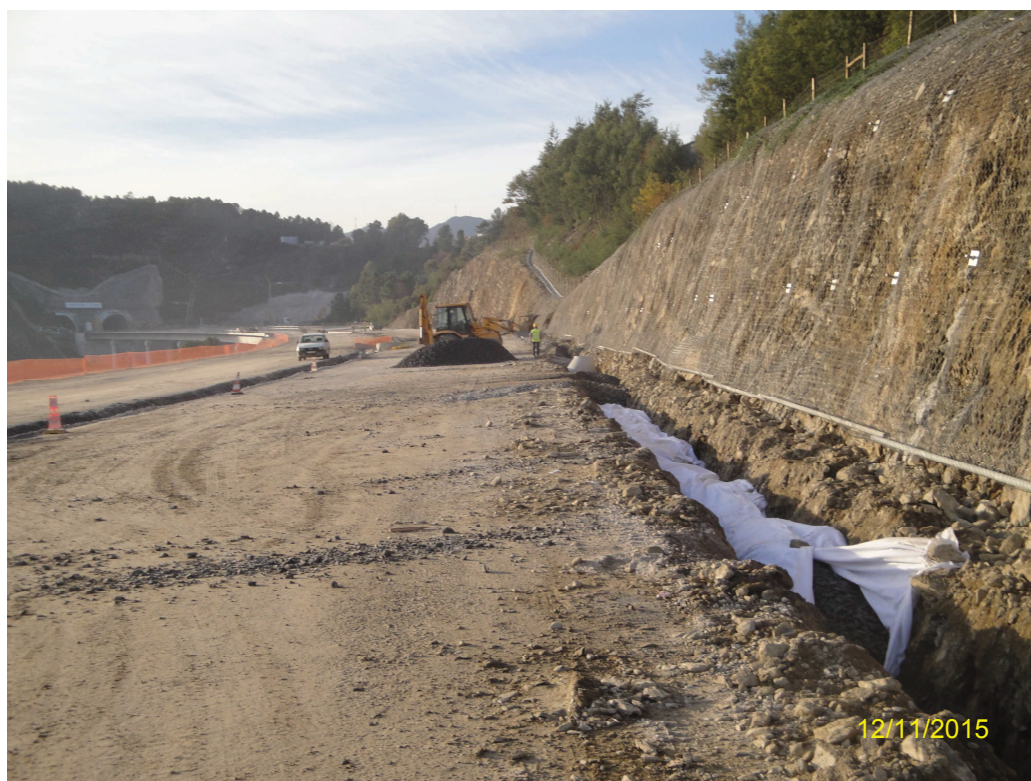
Registo Fotográfico 3 – Trabalhos de Execução de drenagens ao Pk 20+200
