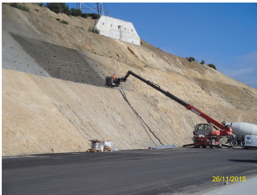
Registo Fotográfico 5 – Execução de betão projetad junto ao Pk 28+600
