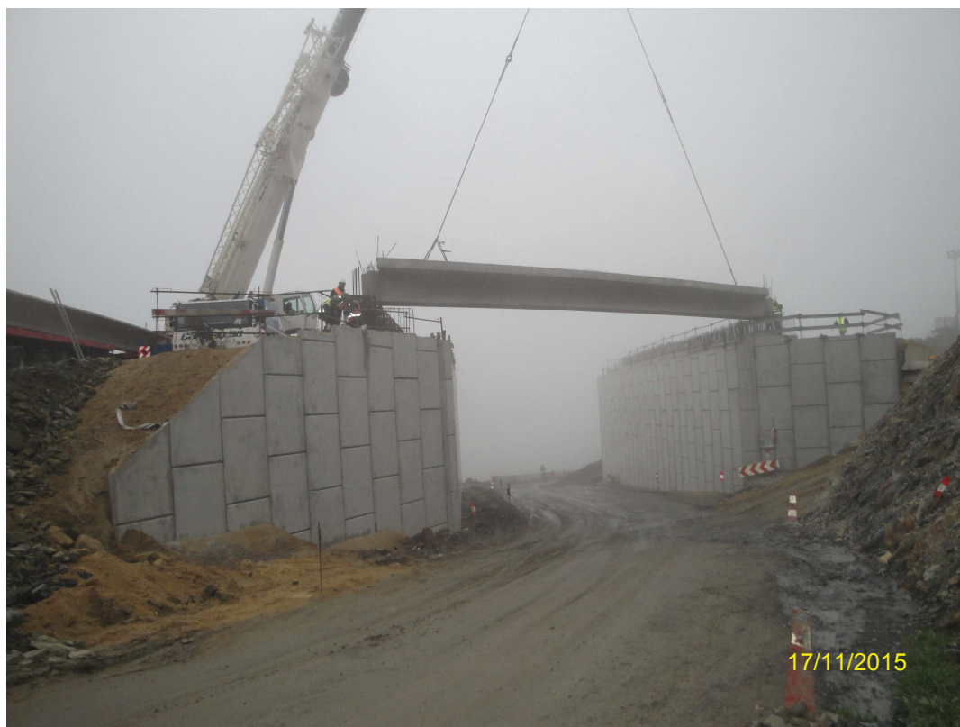
Registo Fotográfico 7 – Montagem de Vigas (PI7B), junto ao Pk 20+255
