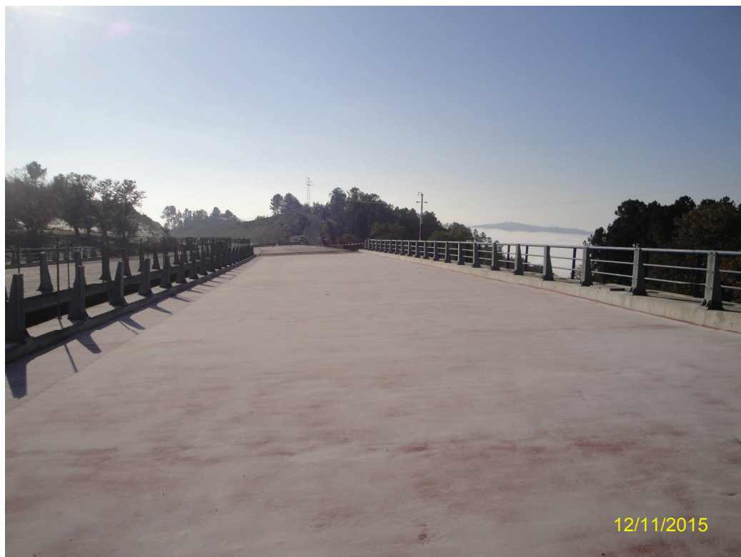
Registo Fotográfico 6 – Impermeabilização de Tabuleiro (Viaduto V11), junto ao Pk 24+600
