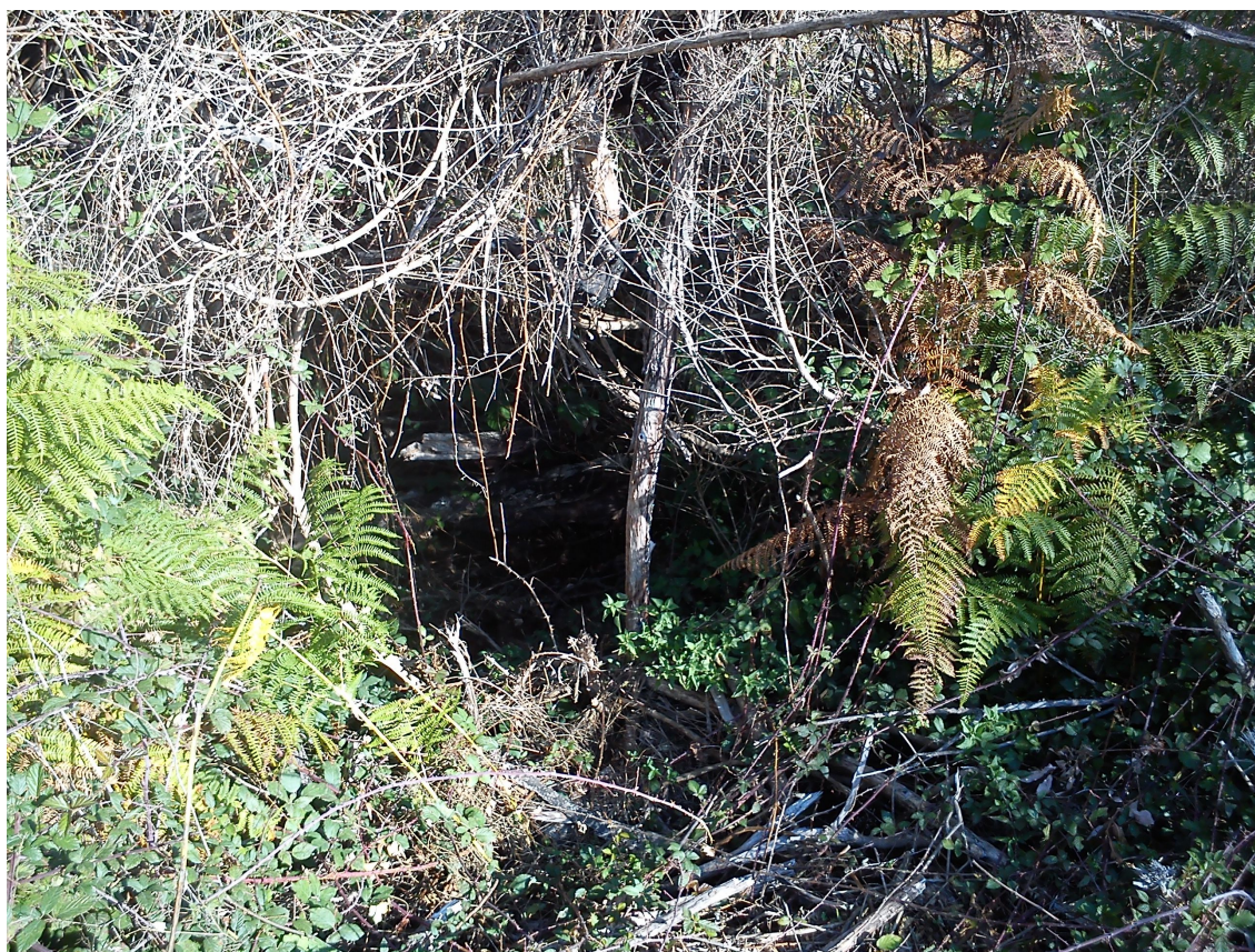
Foto: estado do ponto SUP 11 Montante
