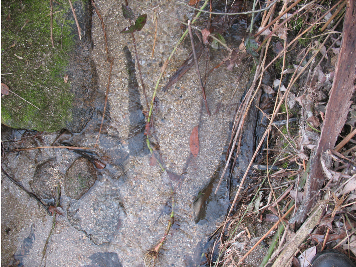
Figura 4:leito e margem esquerda; leito e margem direita do V11-J500
