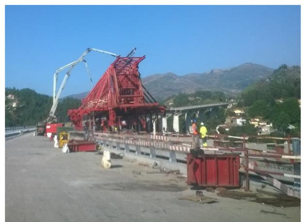
Foto 12 - Betonagem do Tabuleiro Direito
