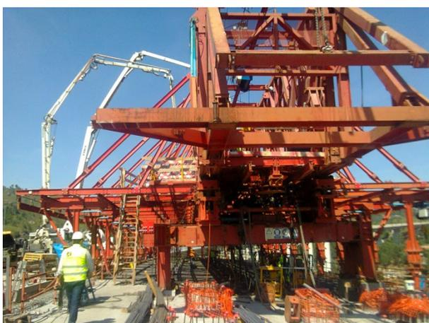
Foto 11 - Betonagem do Tabuleiro Direito
