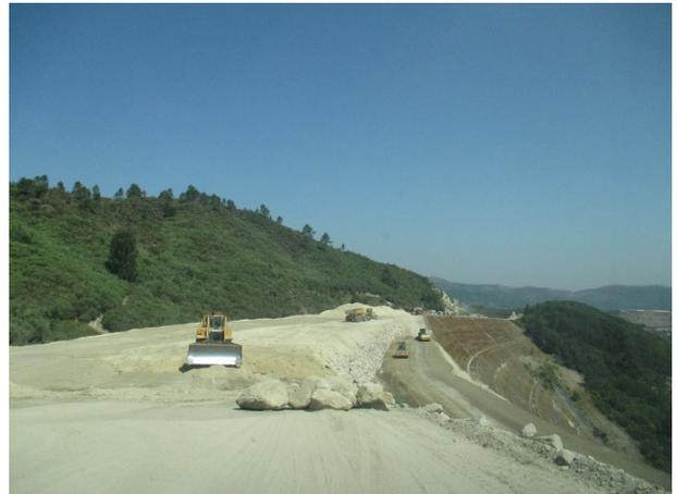
Foto 4 - Muro em solo-cimento M14
