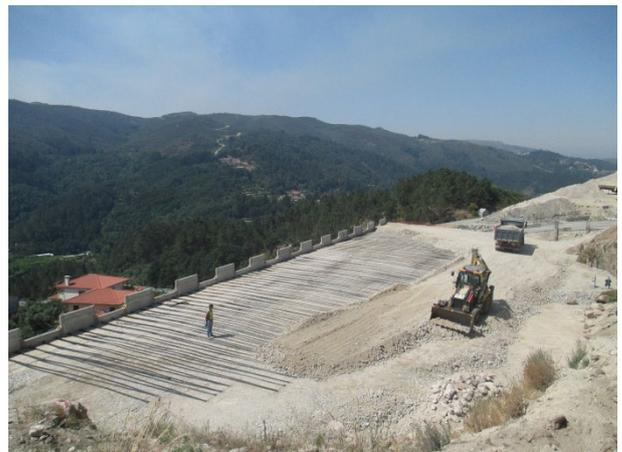
Foto 6 - Muro Terra Armada
