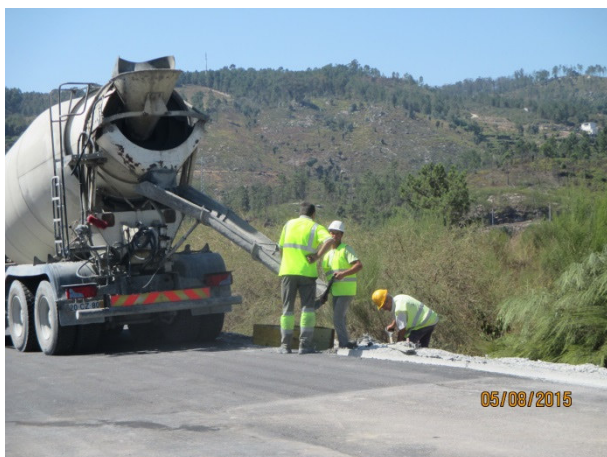
Foto 3 - Betonagem de valetas
