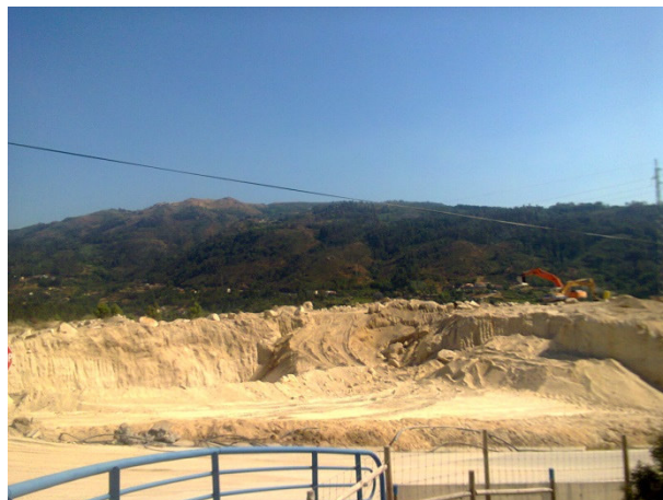
Foto 10 - Escavação do Empréstimo 9
