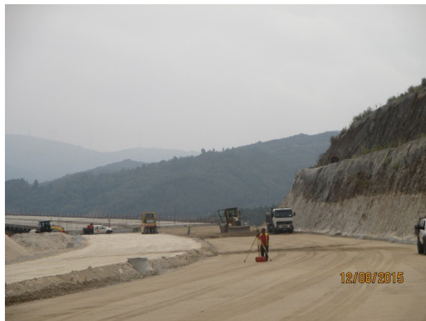
Foto 8 - Pavimentação - Leito Pavimento
