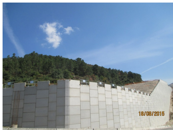
Foto 6 - Muro Terra Armada
