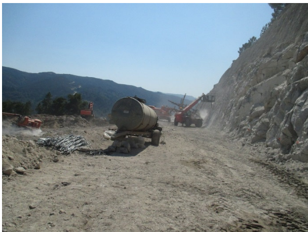
Foto 7 - Muro Pregado - furação e Injeção
