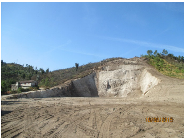
Foto 9 - Escavação do Empréstimo 8
