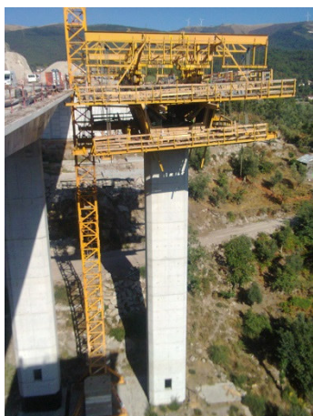
Foto 15 - Montagem de Ferro no Pilar 2 do V5
