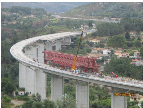
Foto 11 - Trabalhos de preparação para a Betonagem do Tabuleiro Direito do Viaduto 1
