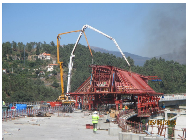
Foto 12 - Betonagem do Tabuleiro Direito Viaduto 1
