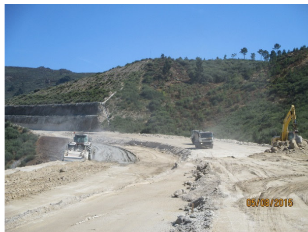
Foto 4 - Muro em solo-cimento M14
