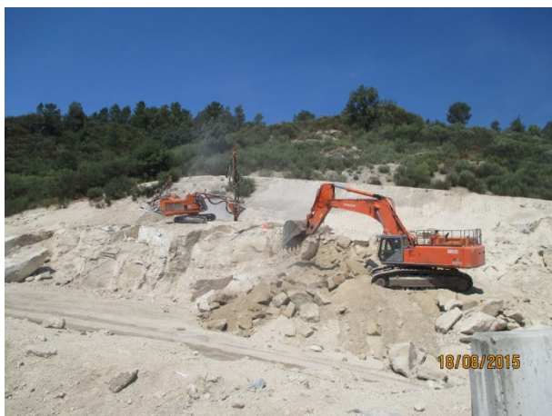
Foto 1 - Escavação e britagem de material
