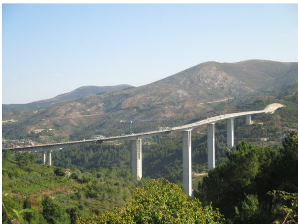
Foto 11 - Vista Geral do Viaduto 3
