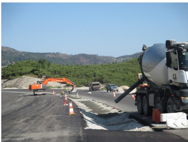
Foto 3 - Betonagem coletor central
