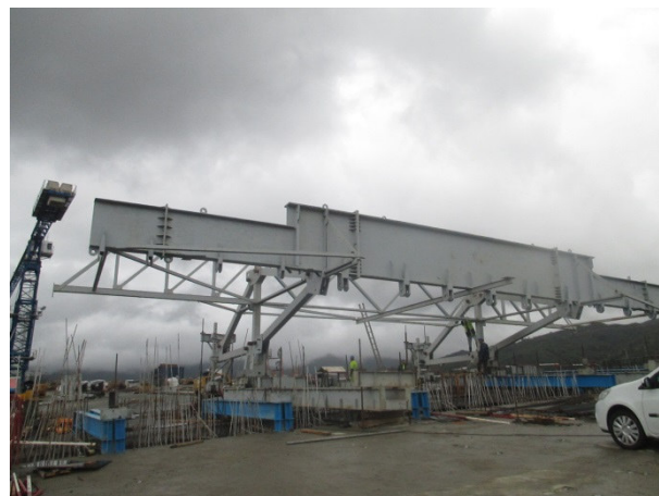
Foto 12 - Preparação para o Fecho do Viaduto 3
