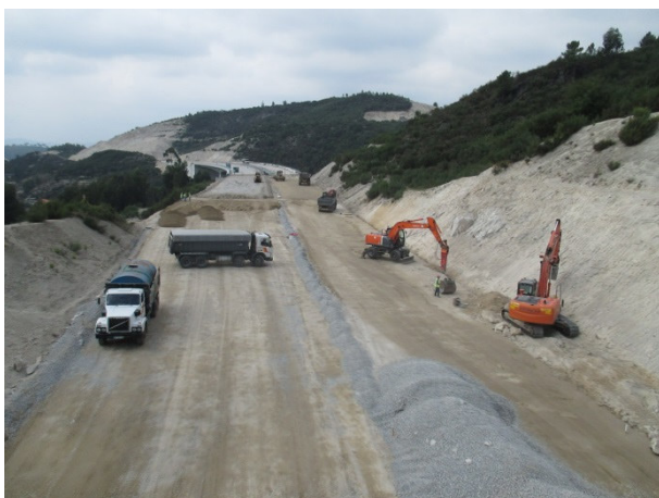
Foto 7 - Preparação para Pavimentação - Leito Pavimento
