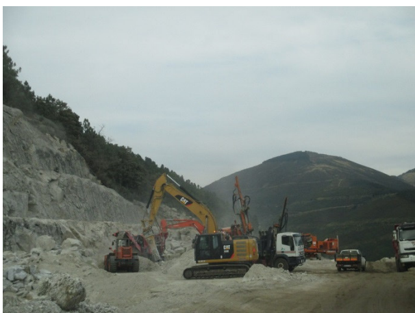
Foto 5 - Escavação e Furação para Desmonte a fogo
