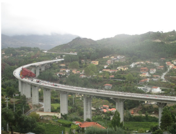
Foto 9 - Trabalhos de preparação para a Betonagem do Tabuleiro Direito do Viaduto 1
