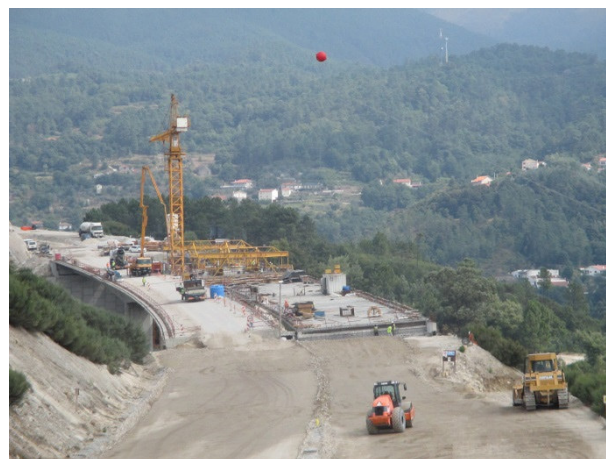
Foto 10 - Betonagem de Aduela do Viaduto 5
