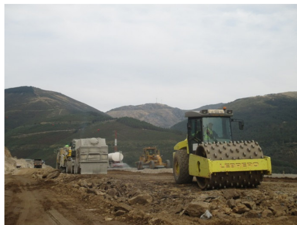
Foto 4 - Muro em solo-cimento M24
