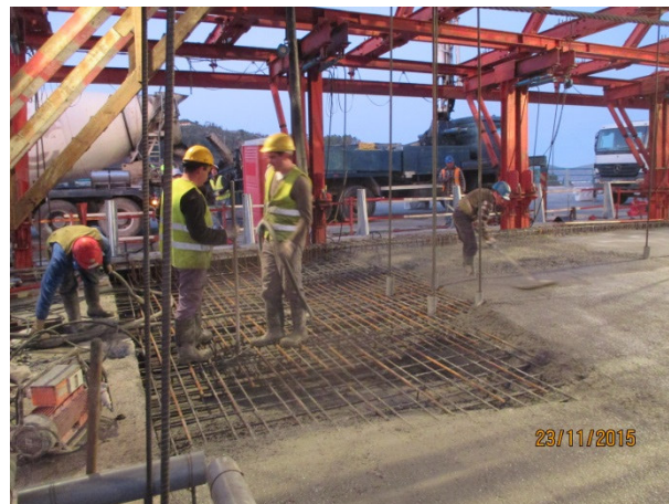
Foto 12 - Betonagem do Tramo P14-P15 (Fecho) do V1
