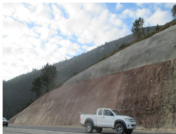
Foto 4 - Execução de Muro Pregado com pigmento
