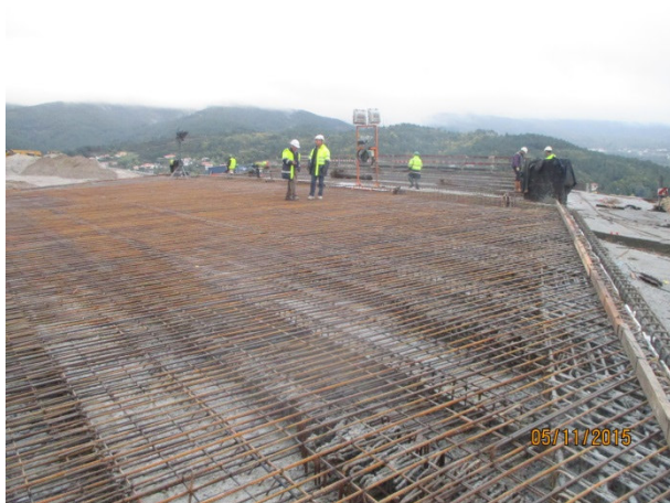
Foto 11 - Montagem de ferro na PI6
