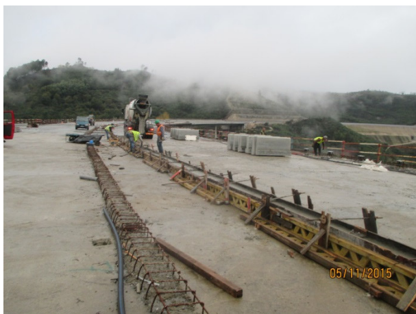
Foto 7 - Separador Central do V3
