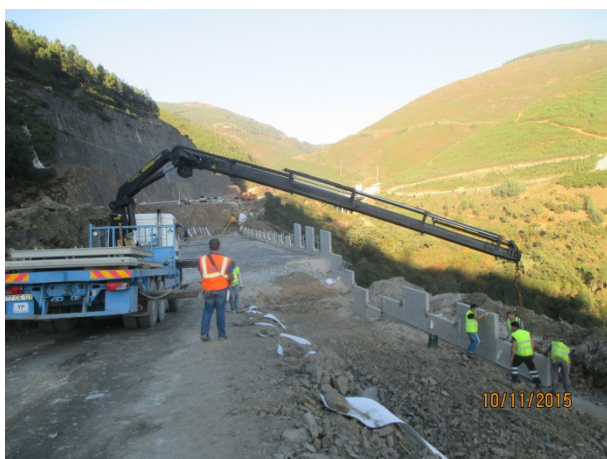
Foto 3 - Execução de Muro de Terra Armada
