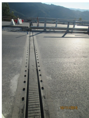
Foto 9 - Juntas de Dilatação V4
