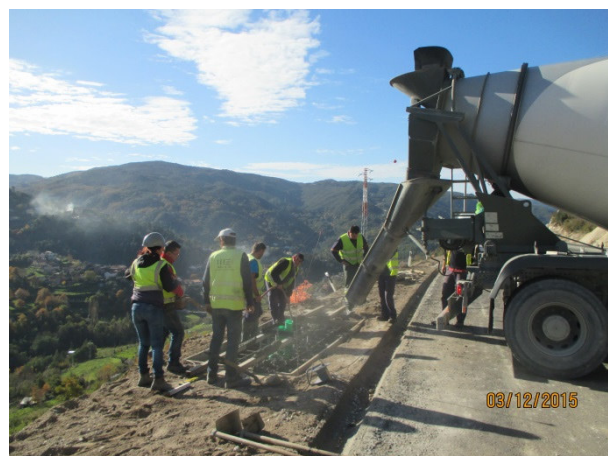
Foto 10 - Betonagem sapata telemática
