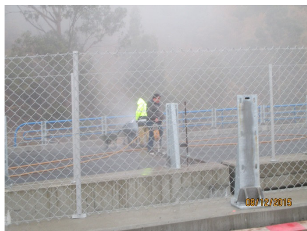
Foto 12 - Execução de Juntas de Dilatação
