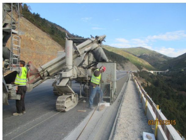
Foto 6 - Betonagem de New Jersey
