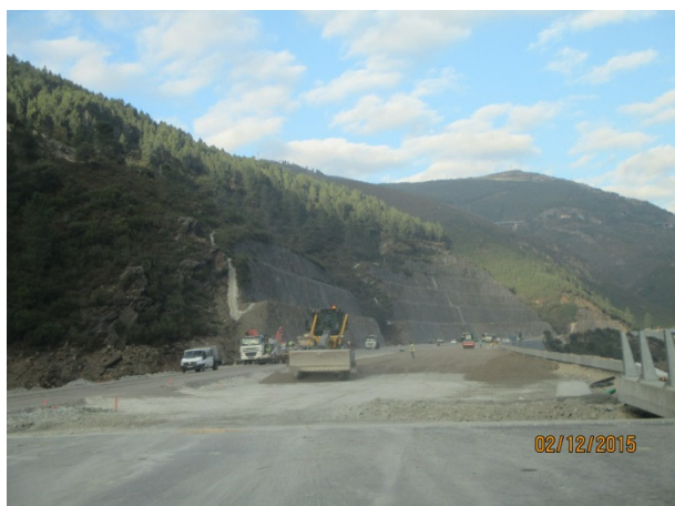
Foto 9 - Leito de Pavimento
