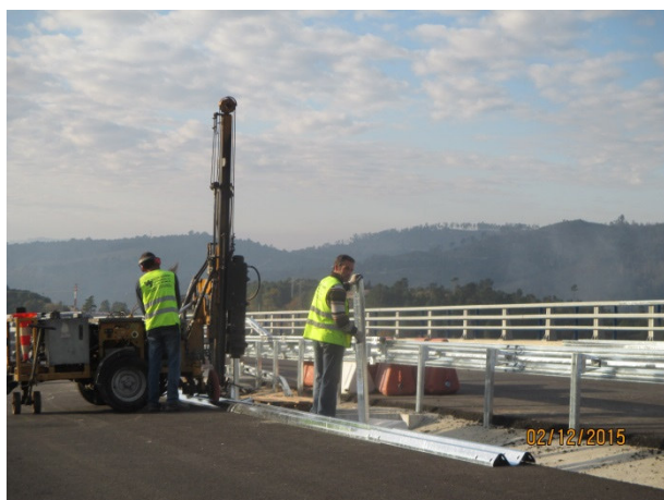
Foto 15 - Montagem de Guardas de Segurança
