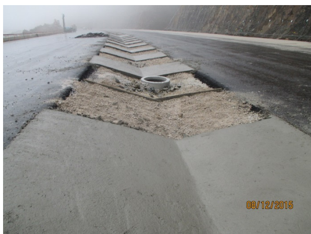
Foto 11 - Betonagem Separador Central
