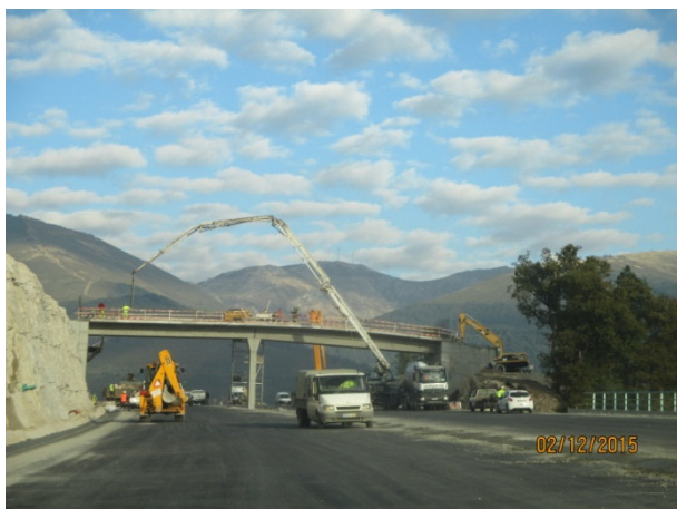
Foto 3 - Betonagem Tabuleiro PP1
