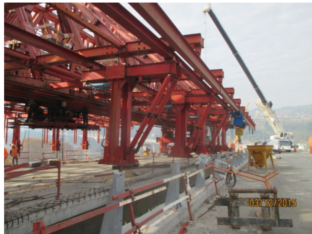
Foto 2 - Desmontagem Viga de Lançamento
