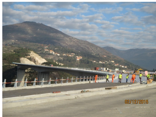
Foto 14 - Impermeabilização Viaduto V3
