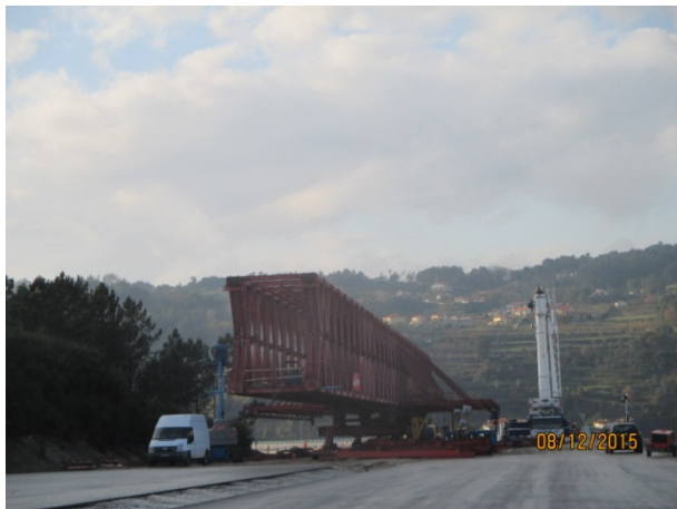
Foto 1 - Desmontagem Viga de Lançamento
