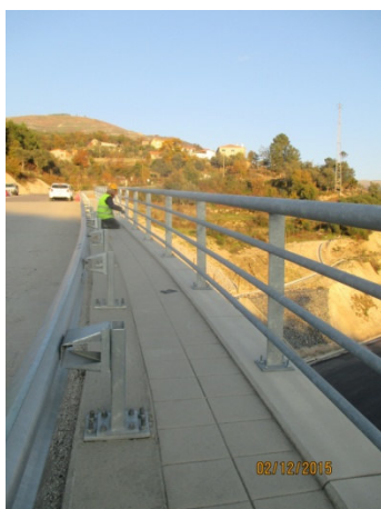
Foto 5 - Pintura de Guarda Corpos PS5
