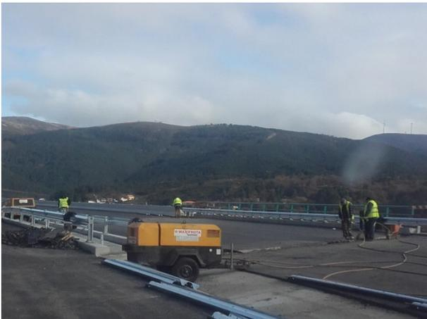
Foto 3 - Execução de juntas de dilatação
